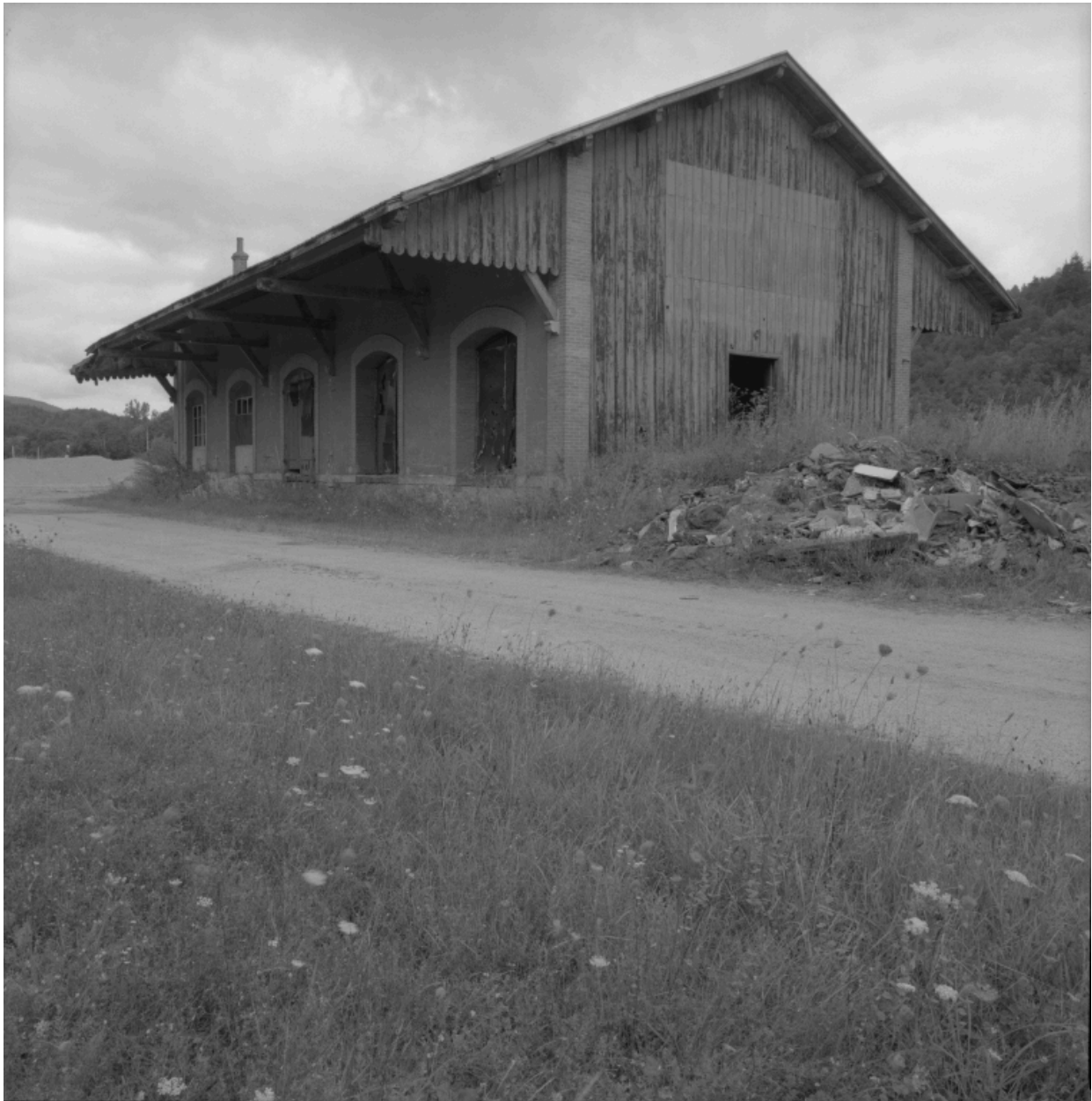
Sail-sous-Couzan, A la Gare, 1986 A 1067. Remise ferroviaire.
