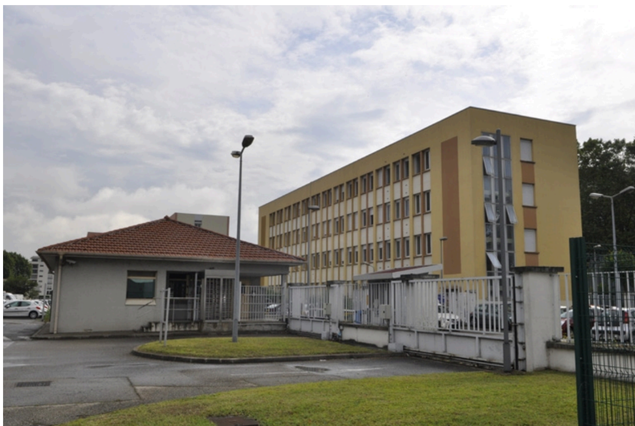
Bâtiment administratif daté des années 50.
