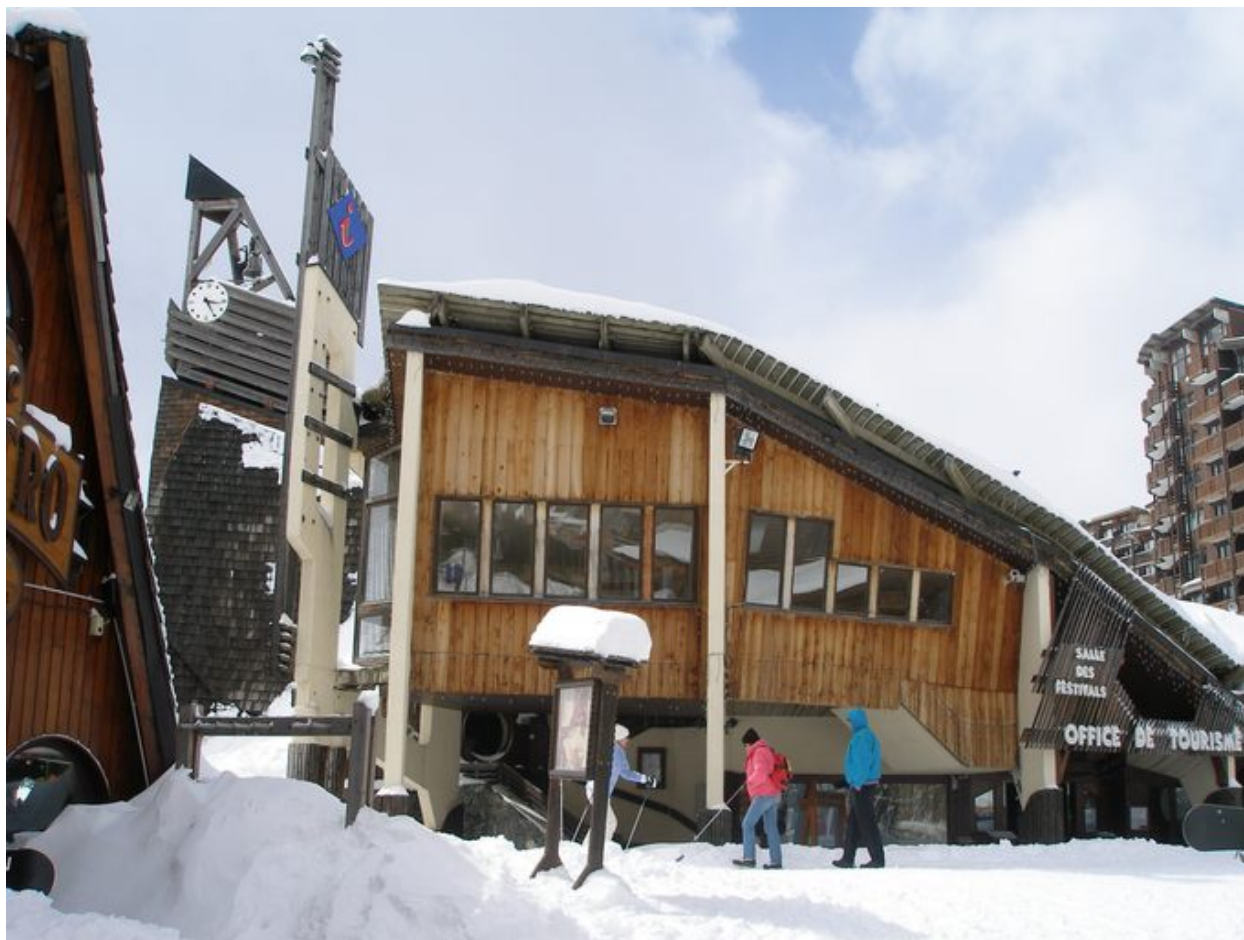
Vue d'ensemble, rue du Festival, depuis le sud-est
