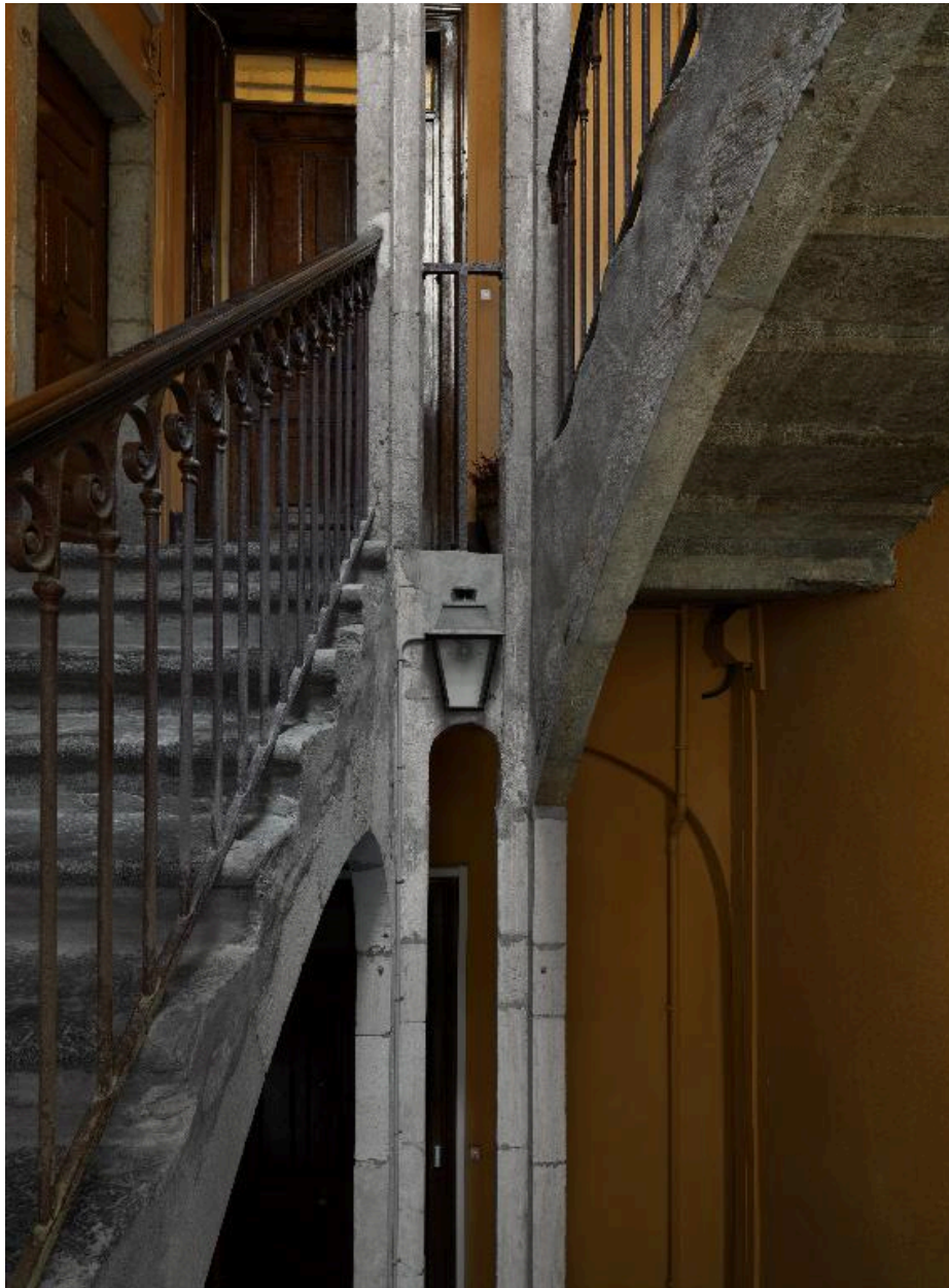
L'escalier nord : noyaux et volées
