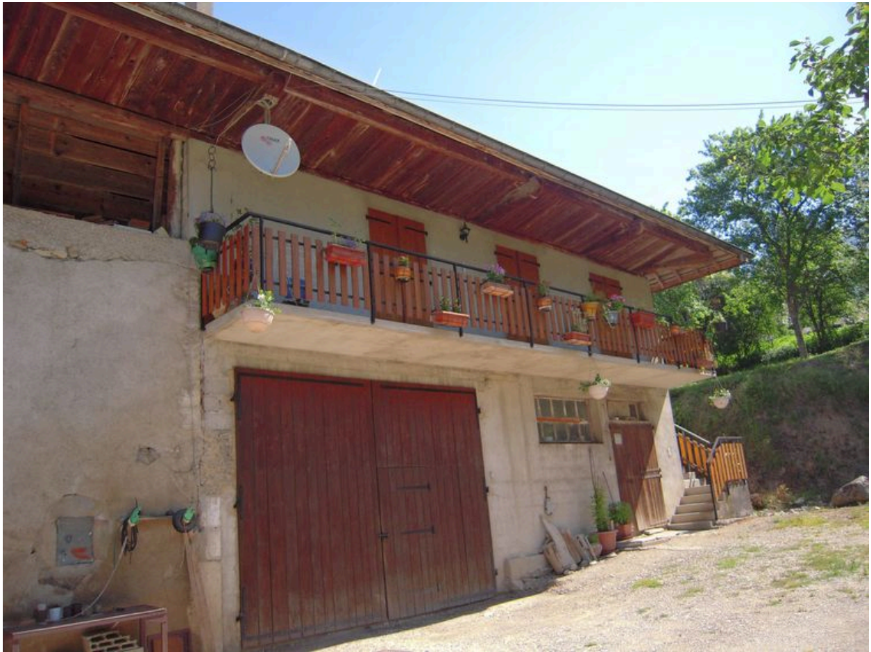
Vue de la partie réaménagée de la façade sud.
