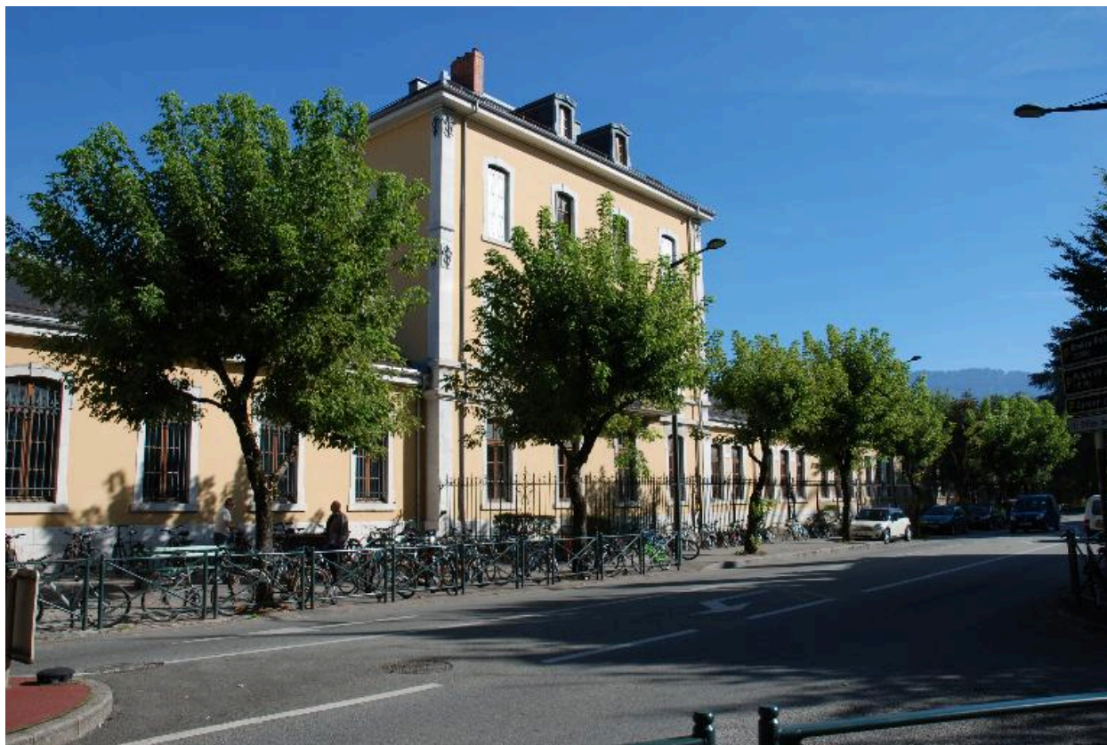
Façade Boulevard du lycée
