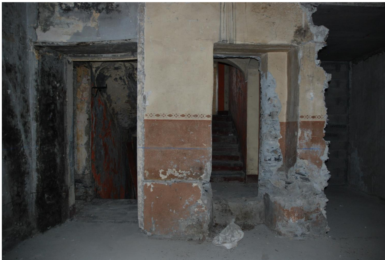
Vue intérieure du 2e étage, depuis le nord : ouvertures vers le palier de l'escalier.
