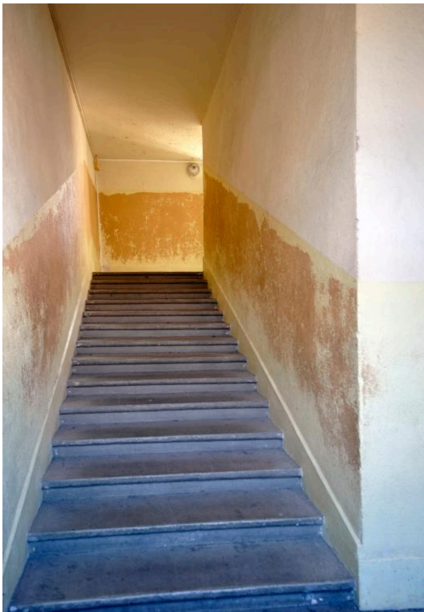
Corps de bâtiment ouest : escalier rampe sur rampe
