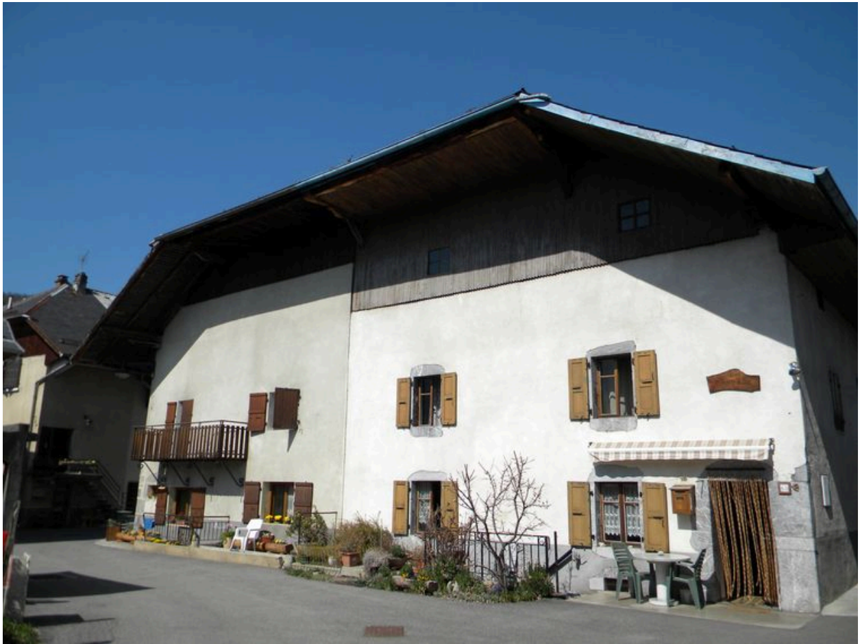
Vue de la façade principale d'une ancienne ferme à juxtaposition accolée à plusieurs habitations. (A2 403,404, 410)
