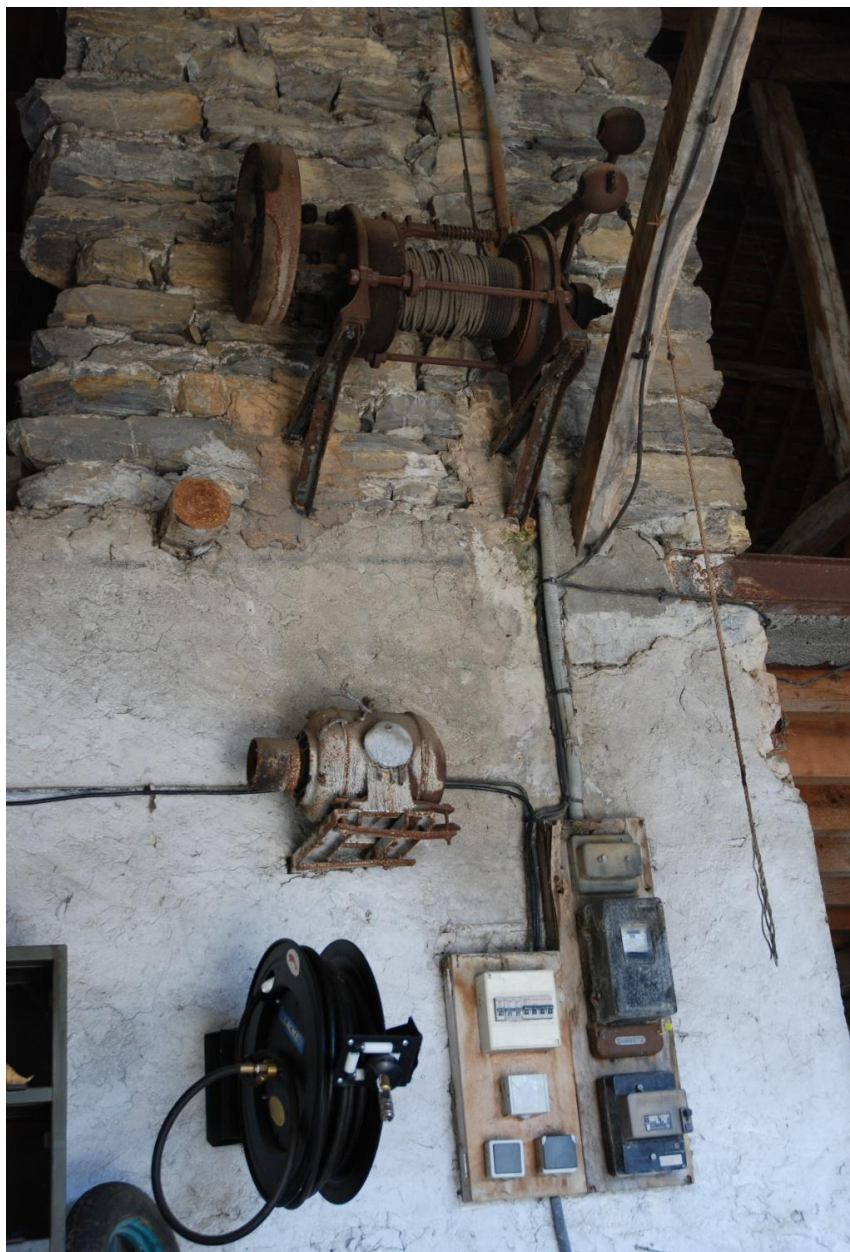
Partie nord. Grange-étable (2018 E1 525, rue Jacques Marret). Détail du treuil monte-foin.
