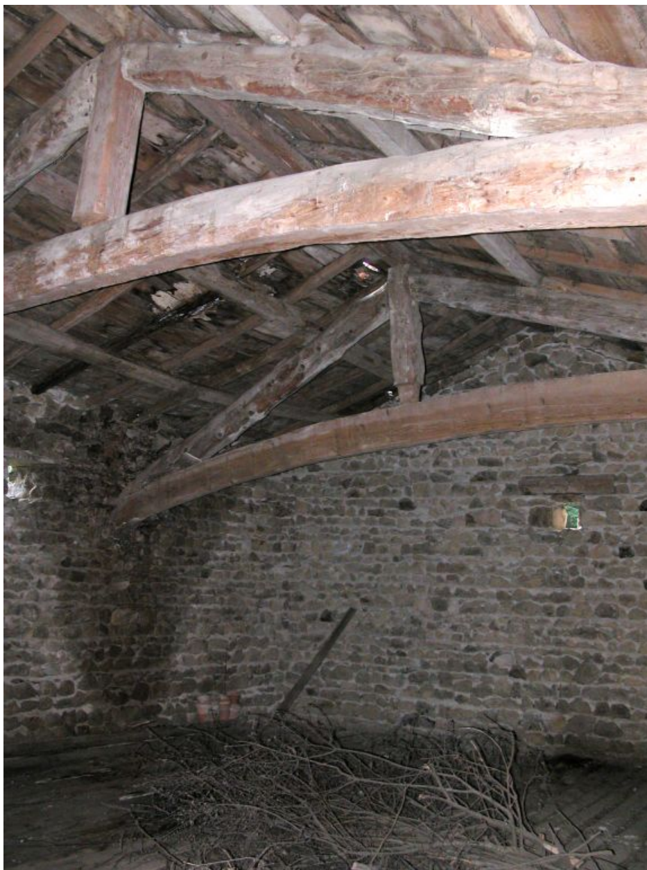
Vue d'ensemble intérieure de la grange vers le sud avant.
