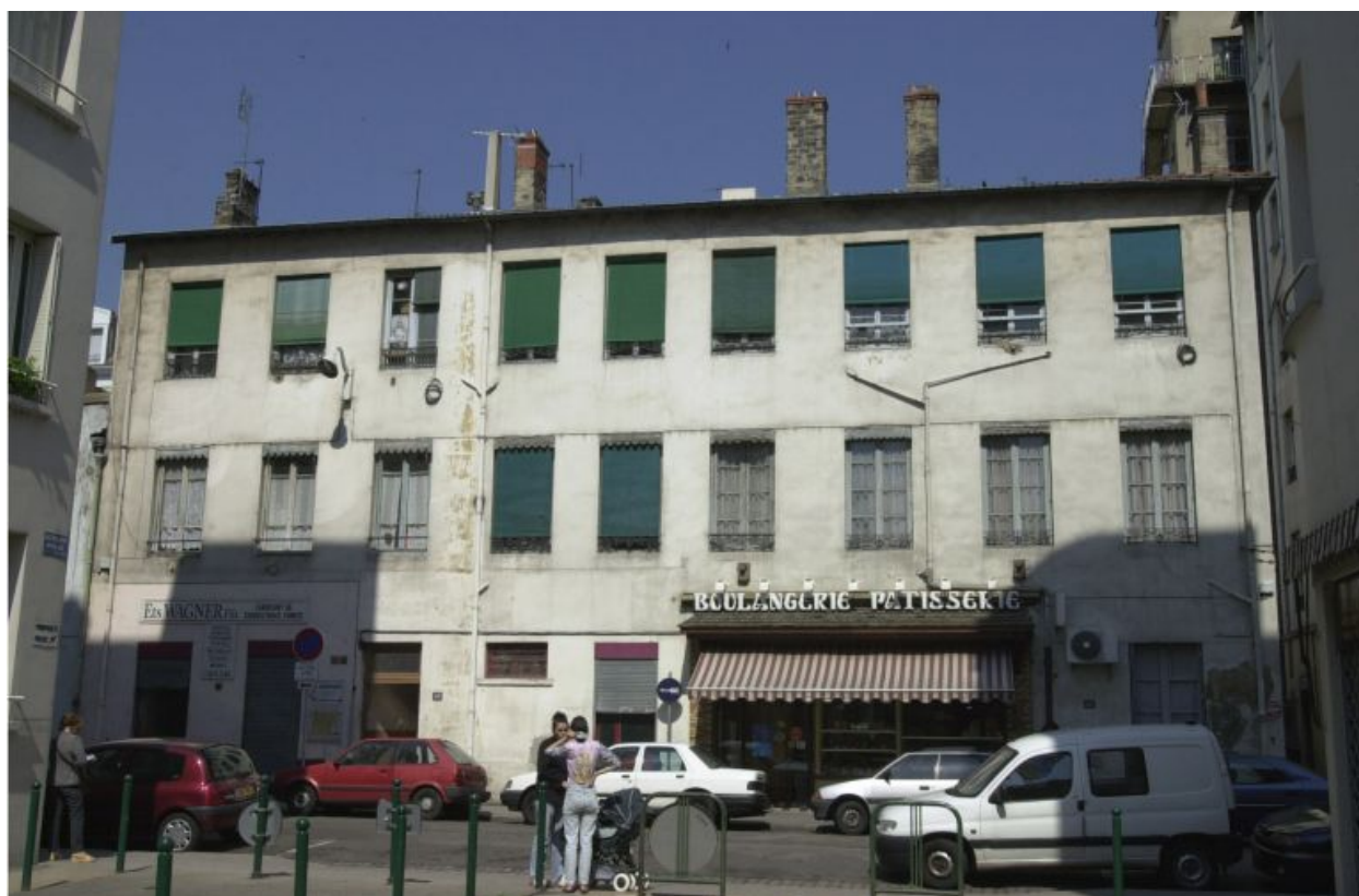
Elévation principale, rue Delandine
