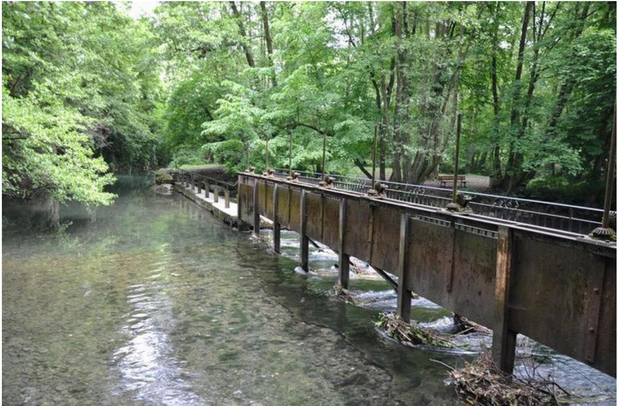
Vue sur les vannes du barrage mobile de la cartonnerie Aussedat
