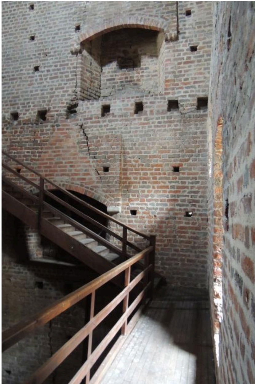
Donjon : intérieur, mur est, cheminées des niveaux 1 et 2.
