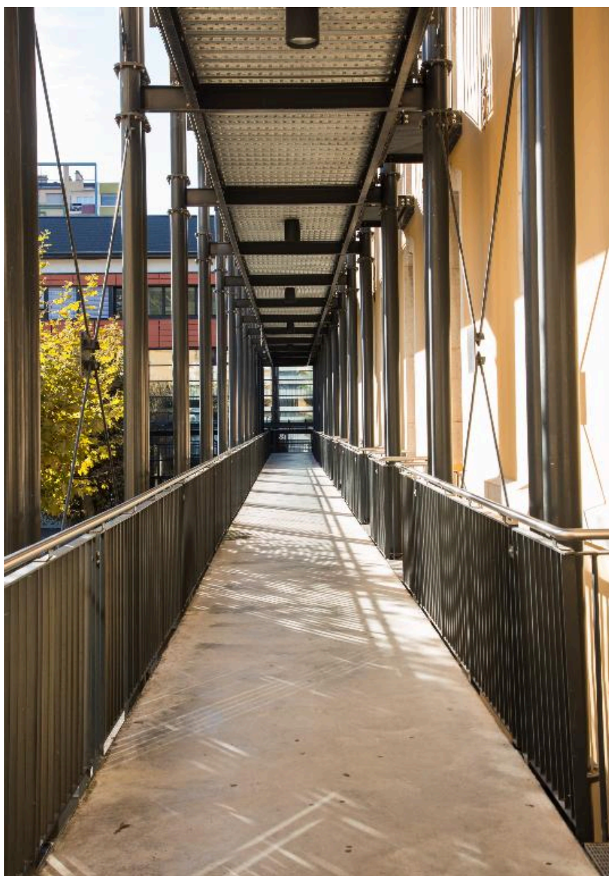
Cour 3, galerie à R+1, desserte des salles de cours.
