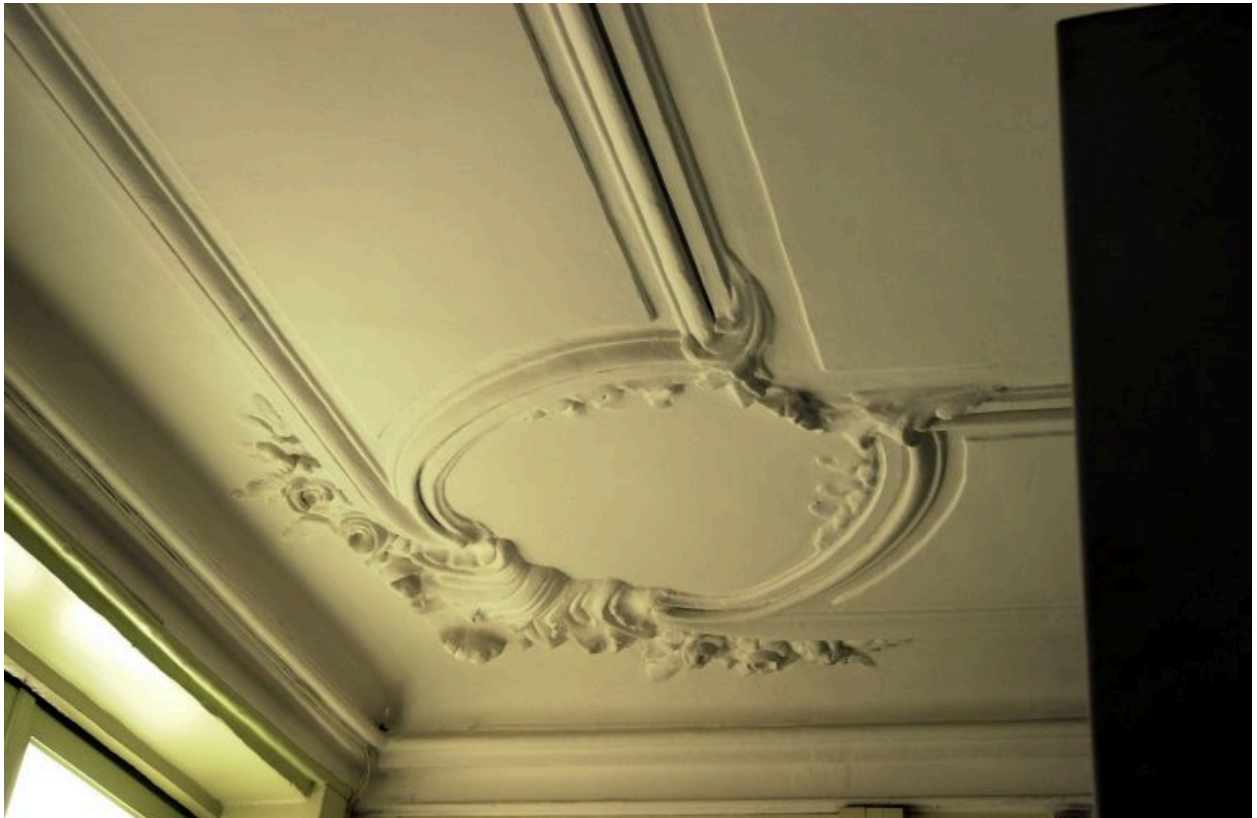
Plafond de la cage de l'escalier principal, détail de l'angle sud-ouest
