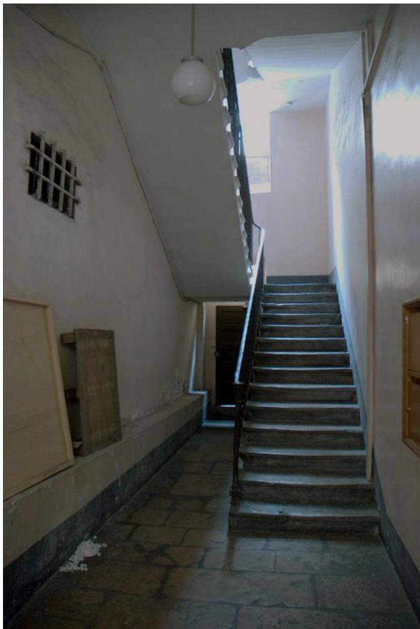
Première volée de l'escalier
