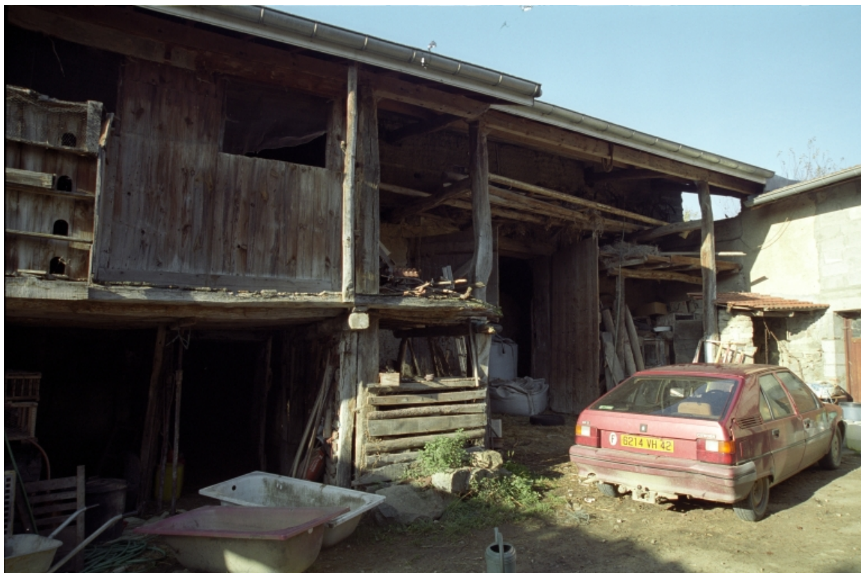
Vue d'ensemble de la grange-étable.
