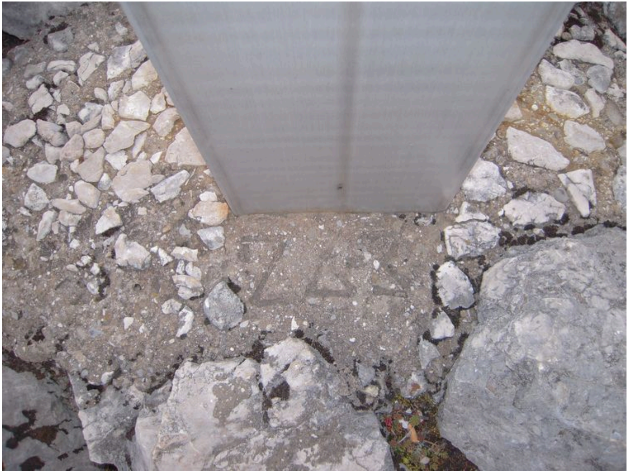
Vue de l'ancrage de la croix.
