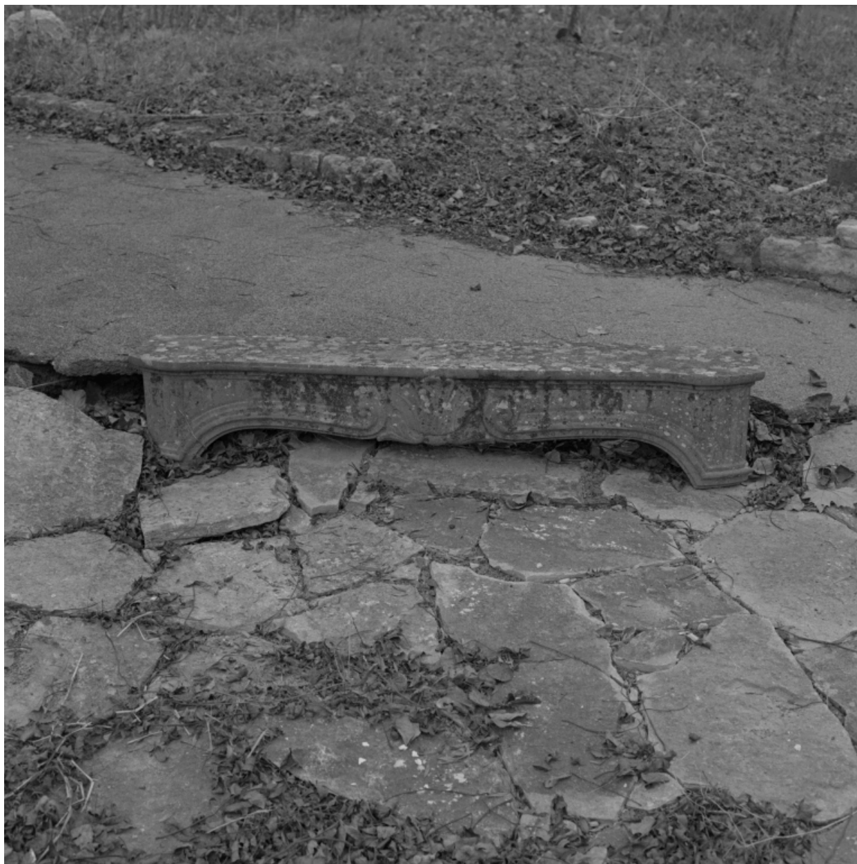
Linteau déposé dans la cour.
