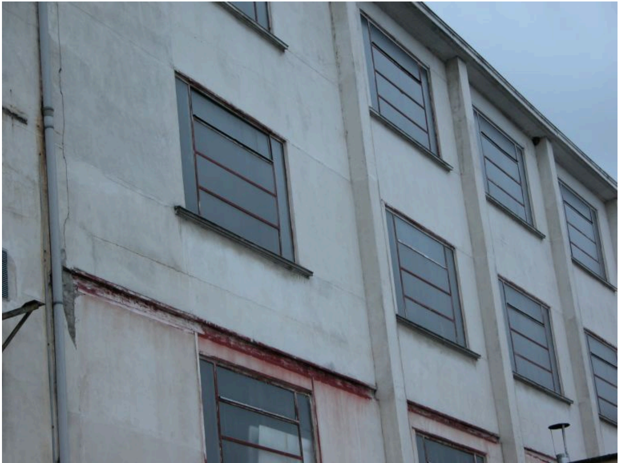
Détail de baies de l'élévation sud de l'aile nord de l'usine.
