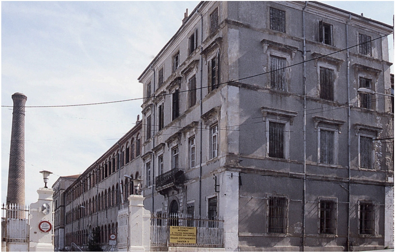
Vue sud-ouest du pavillon d'entrée
