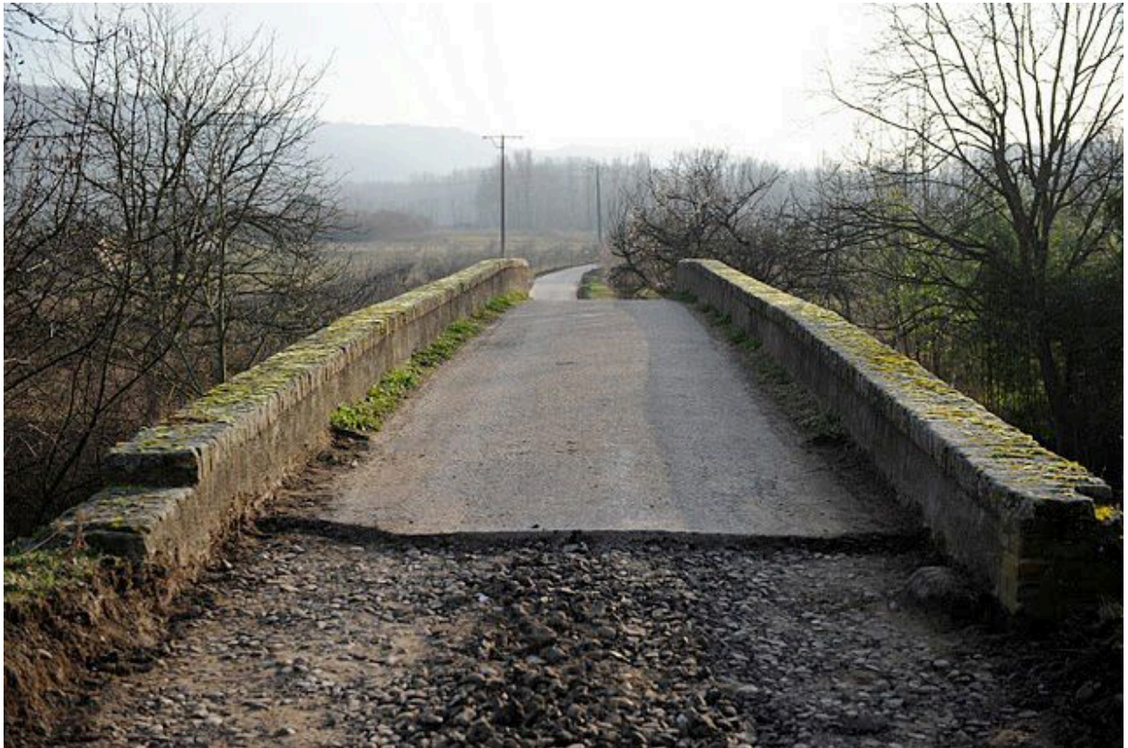
Vue sur la chaussée
