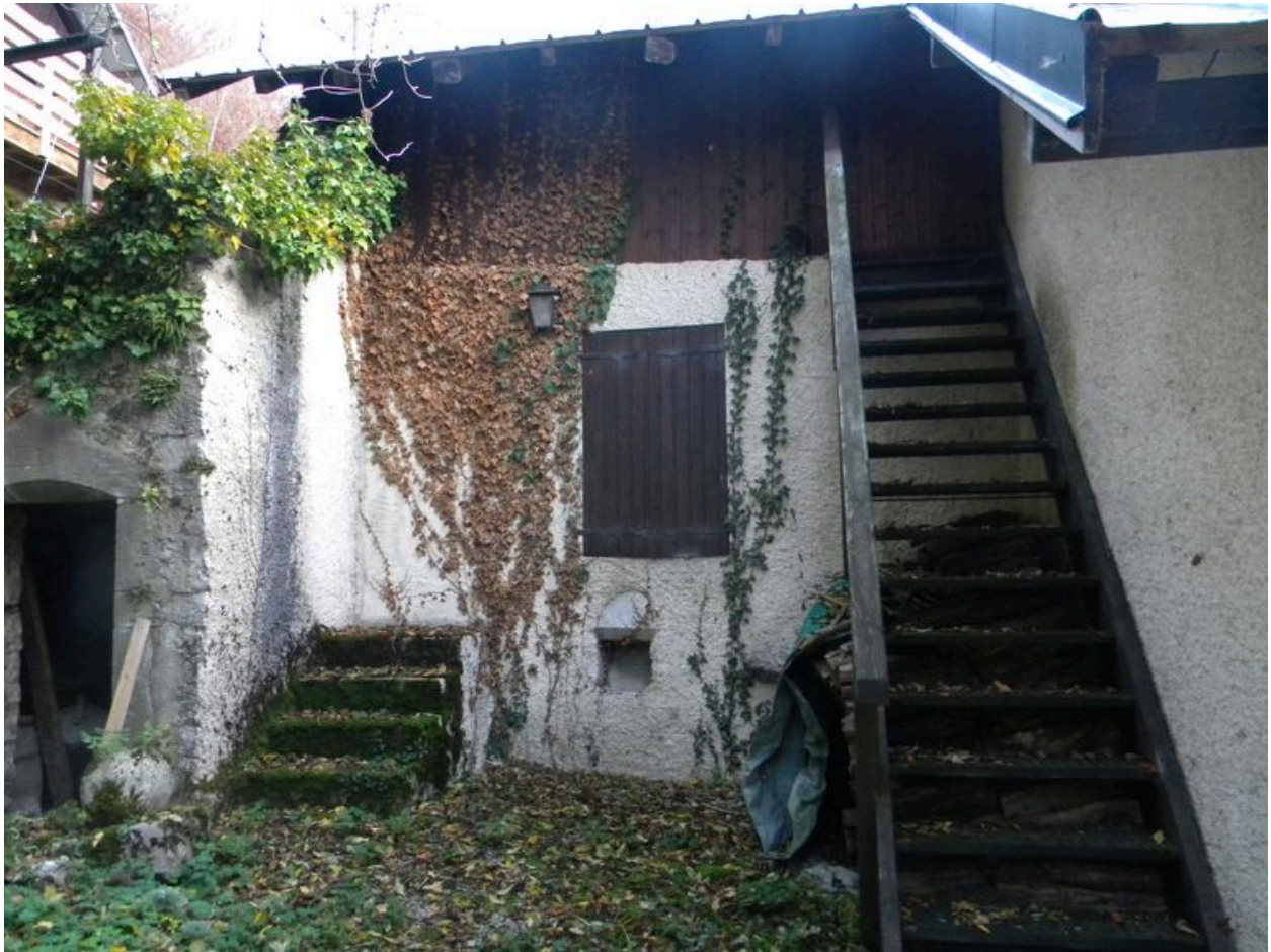
Vue de la partie centrale de la façade nord-ouest avec les traces d'un ancien escalier.
