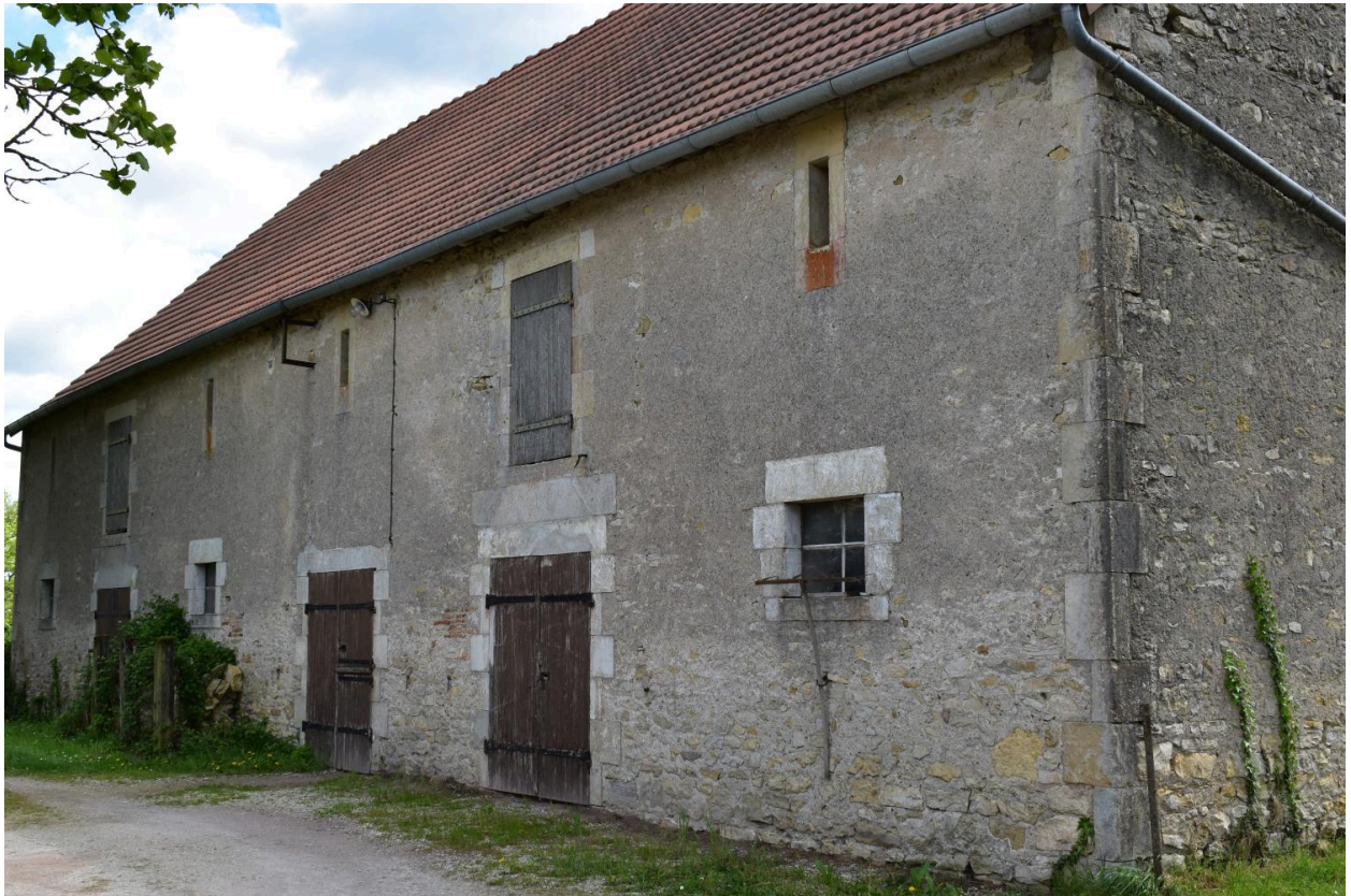
Vue de trois quarts de la grange sud.
