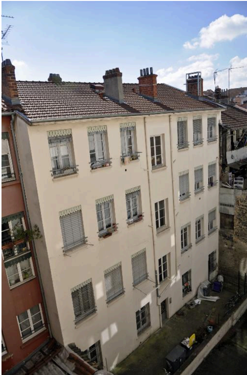
Vue générale, élévation sur cour
