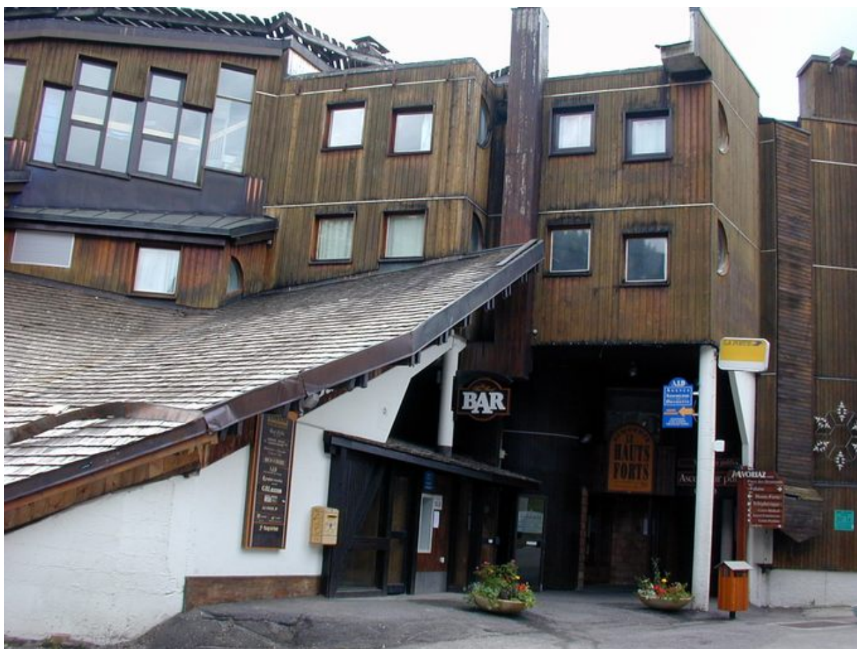
Entrée vers la galerie principale au rez-de-chaussée
