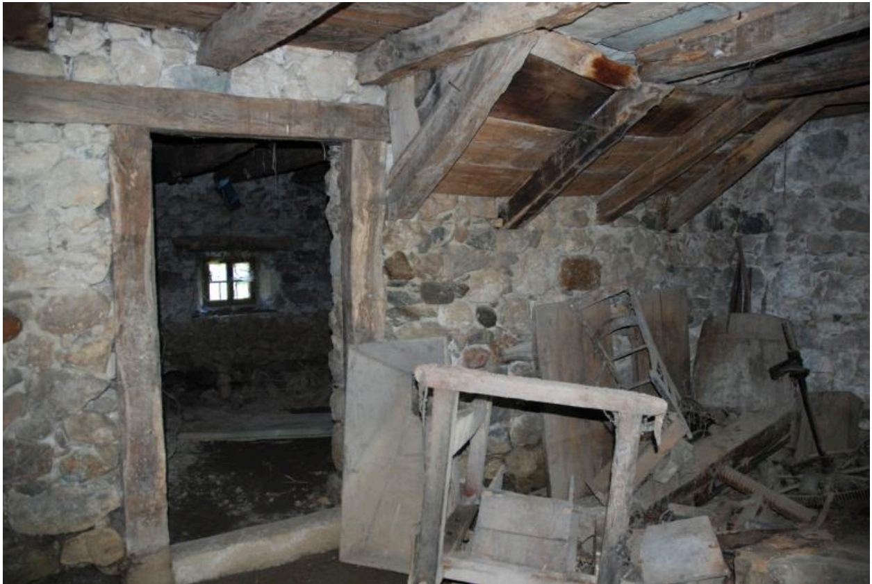
Vue intérieure du cuvage, porte de communication vers la cave nord-est.
