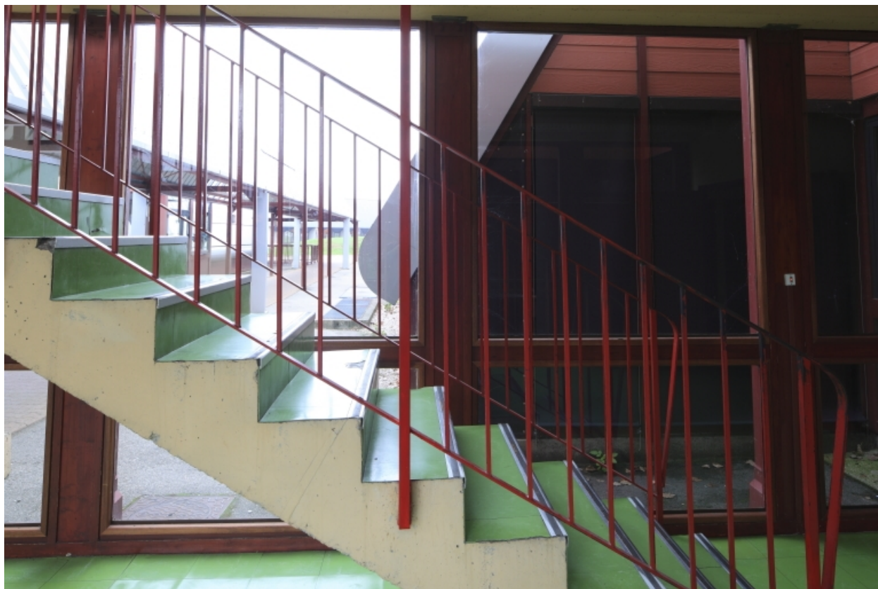
Bâtiment A, escalier intérieur menant du rez-de-chaussée au 1er étage.
