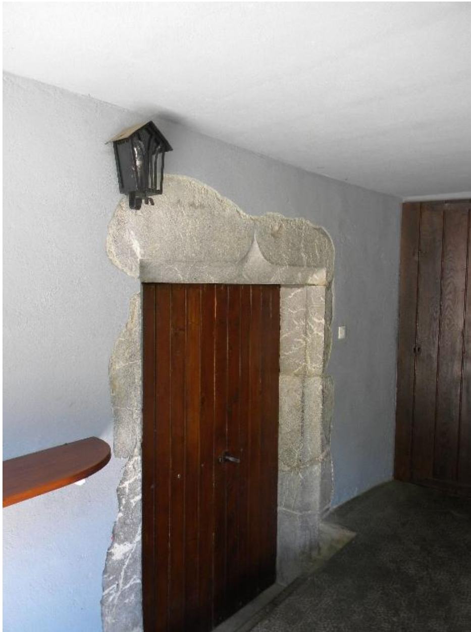
Détail de la porte de l'étable en façade arrière.
