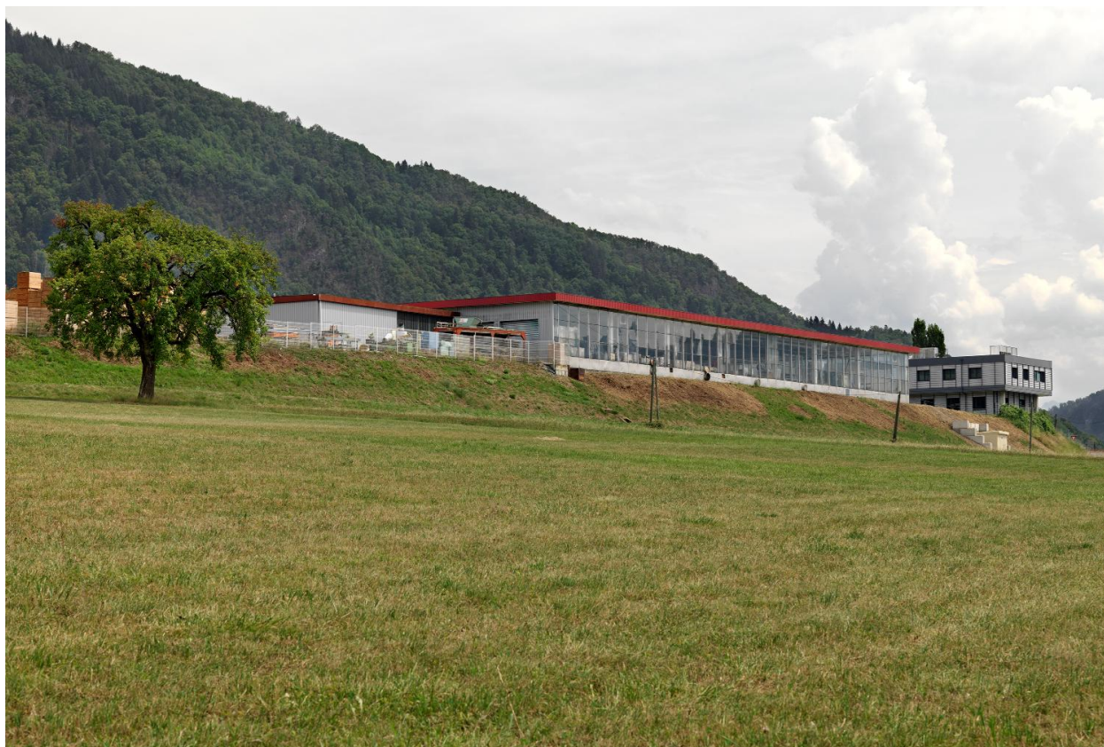
Vue d'ensemble sud-ouest de l'usine
