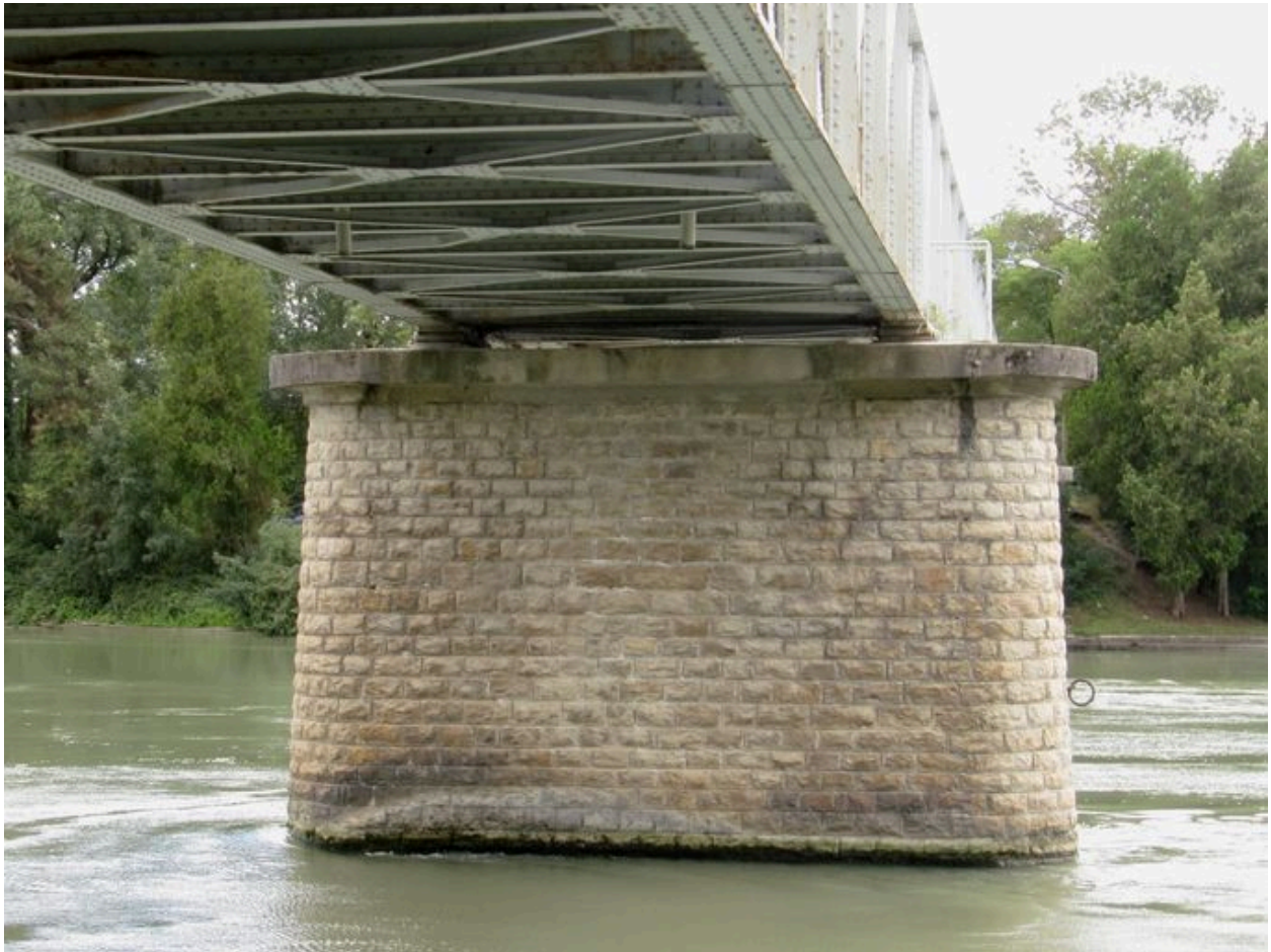
Pile, de côté, vue générale (depuis la rive droite)
