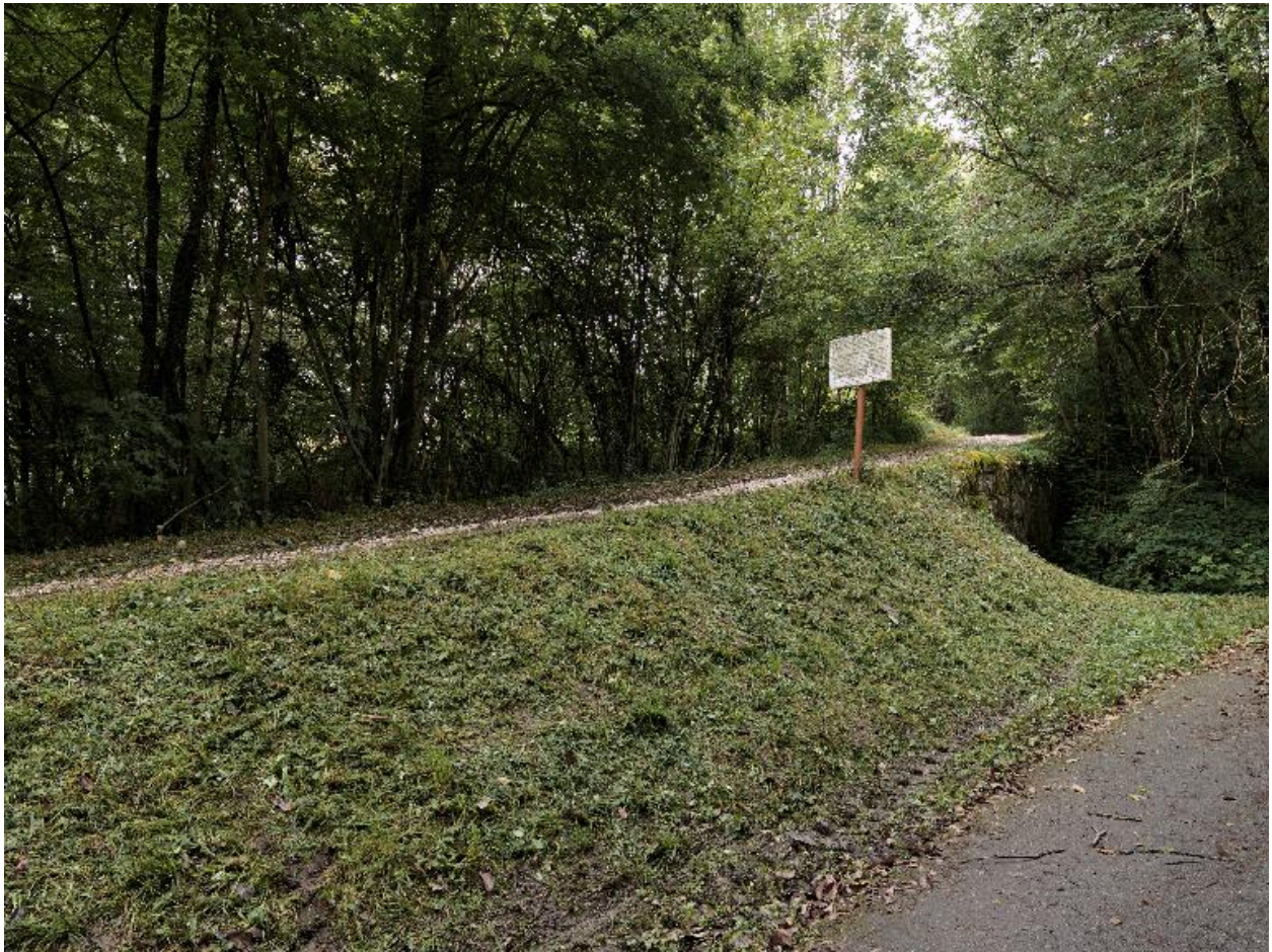
Varnaz (commune de Pugny-Chatenod), NC (vers 2014 B4 529), accès au pont du train à crémaillère enjambant un ruisseau.
