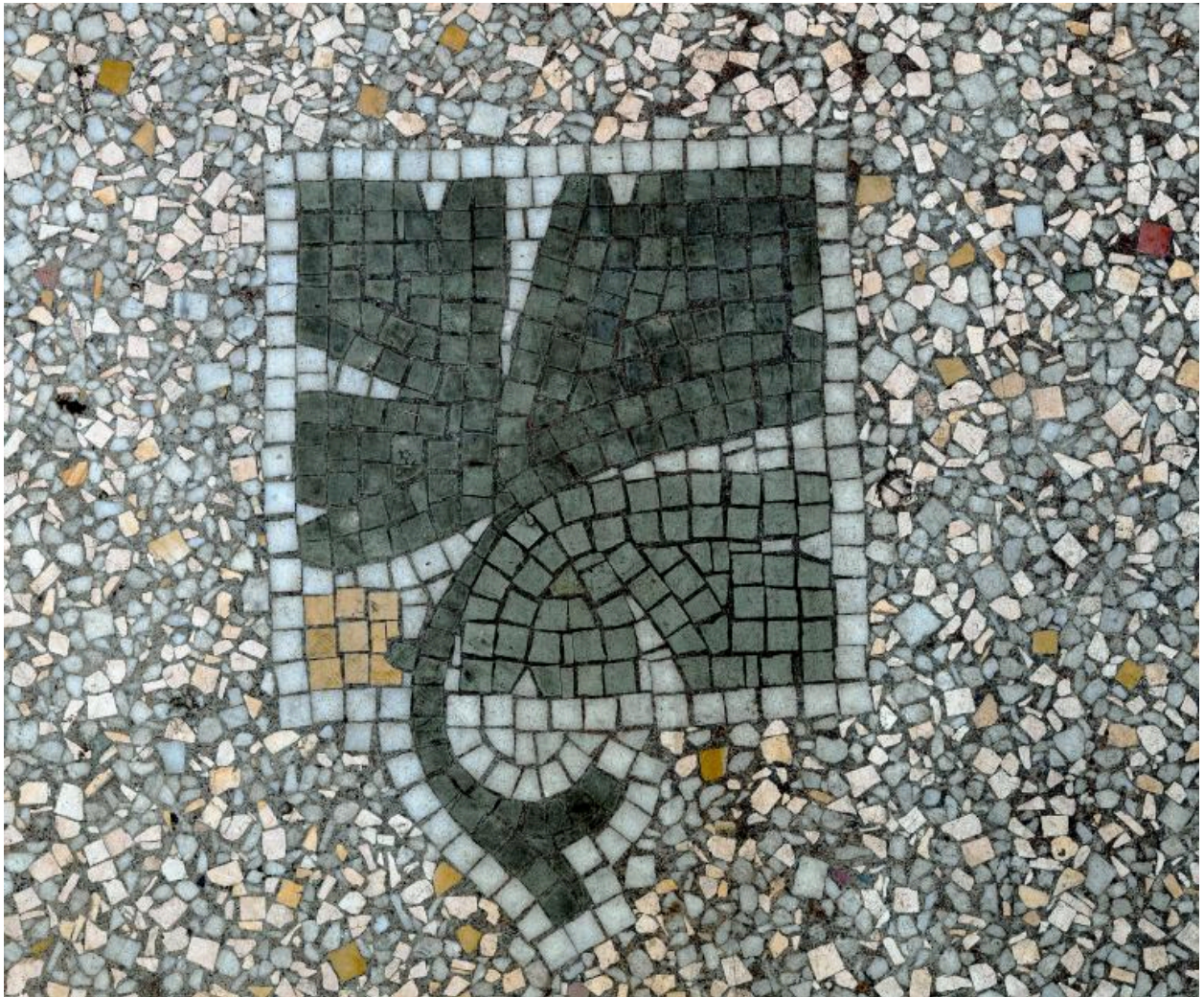
Brasserie La Taverne : revêtement de sol en mosaïque et granito, motif feuillagé
