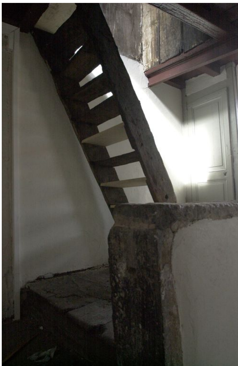
L'échelle de meunier d'accès aux combles
