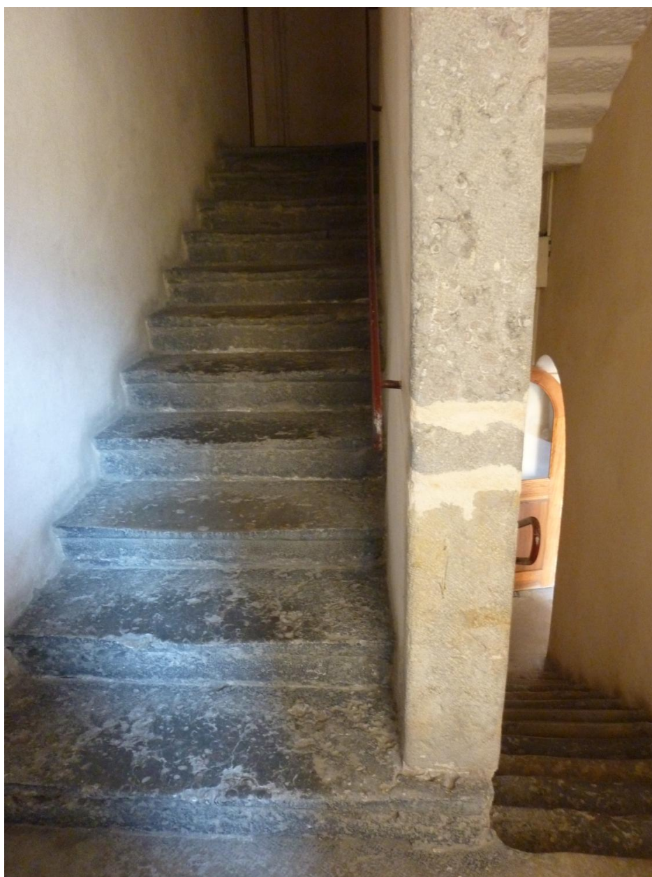
Vue des escalier mur noyau plein
