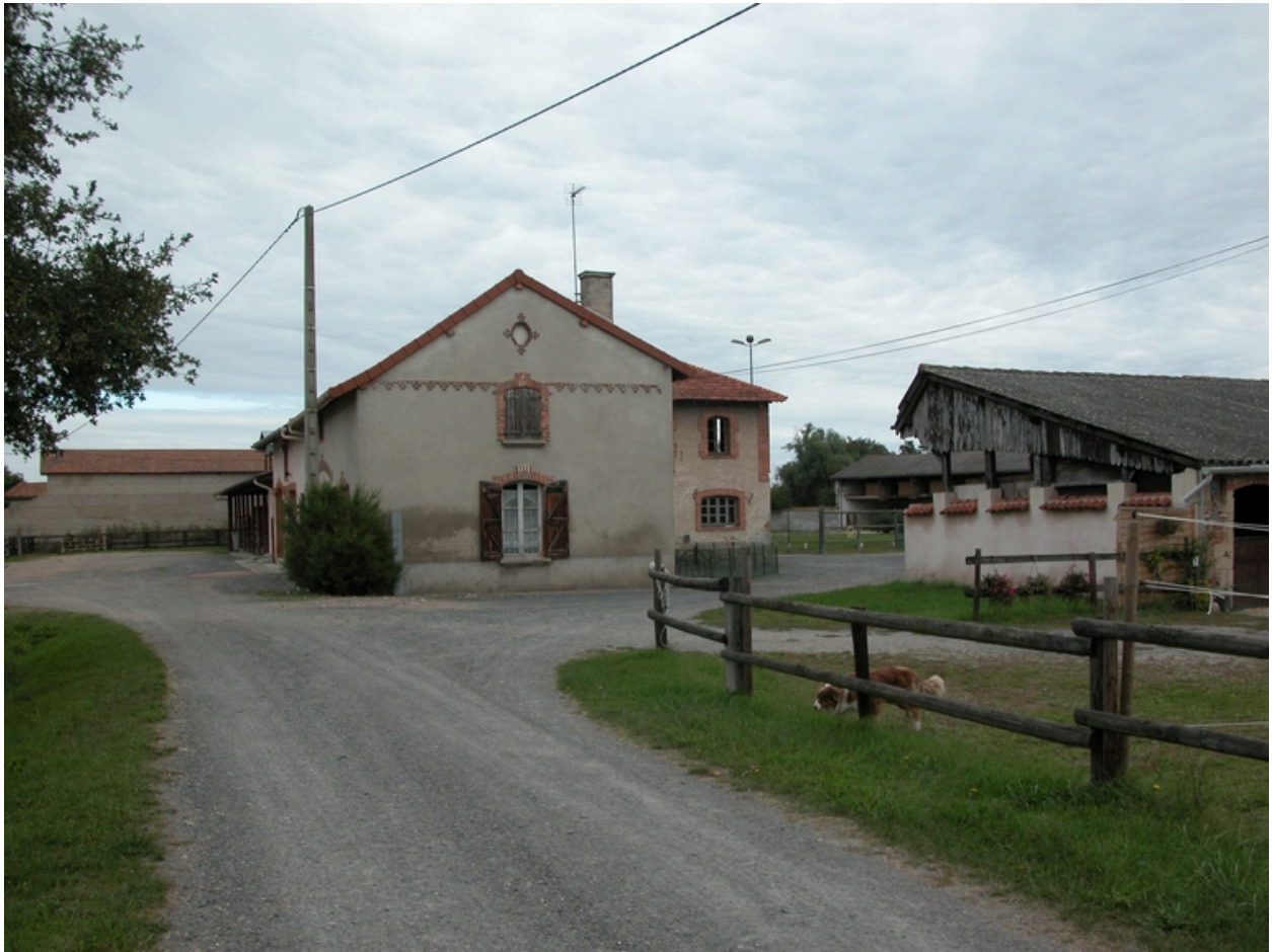
Vue d'ensemble des bâtiments ouest de la deuxième cour, depuis le sud-ouest.
