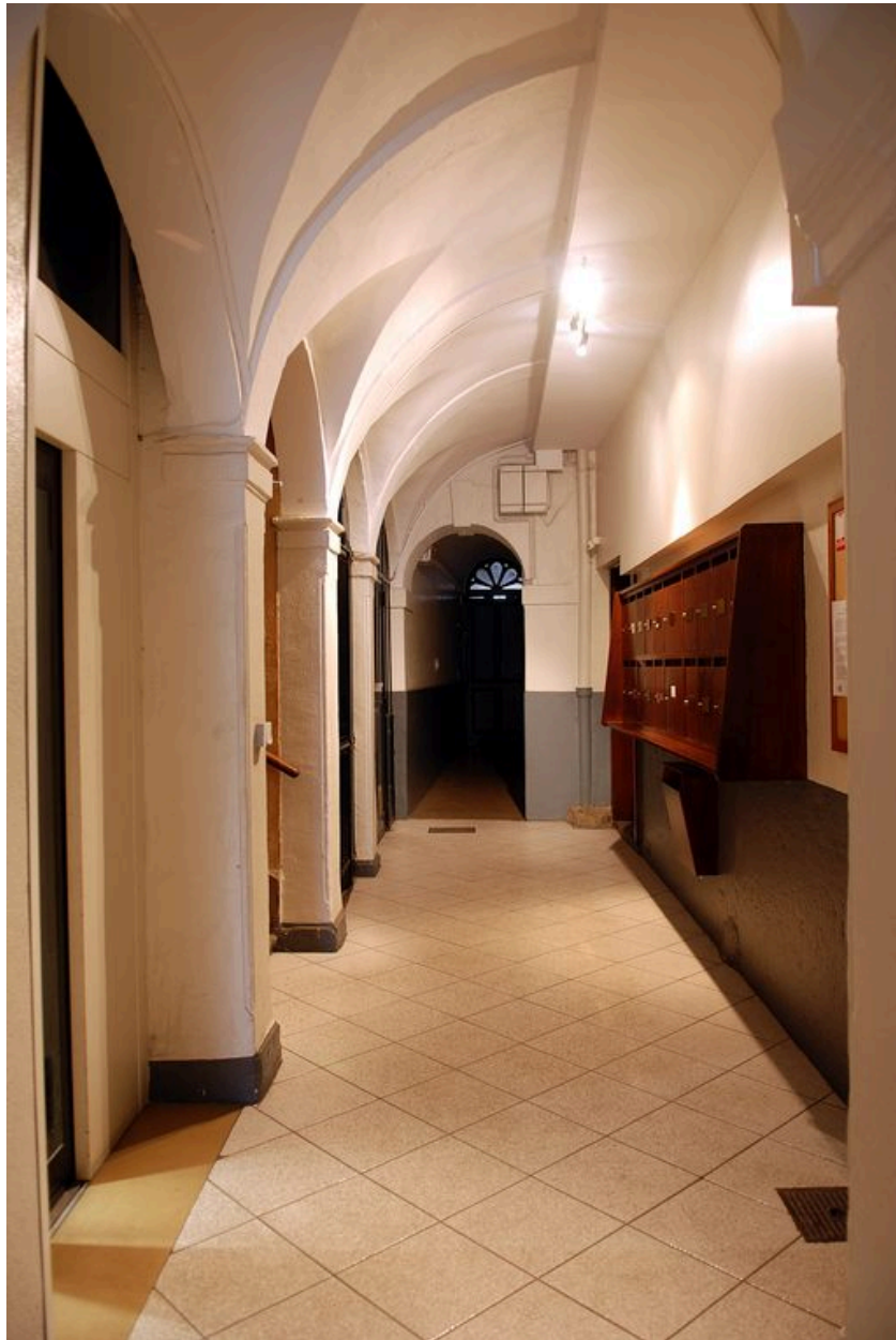
L'allée au niveau du départ d'escalier
