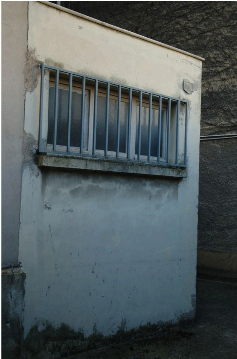
Vue du revers de la sacristie (devant être détruite) en octobre 2011.
