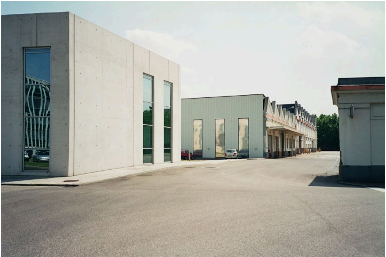
Vue d'ensemble est, au premier plan nouveau centre de recherche Nexan Monde
