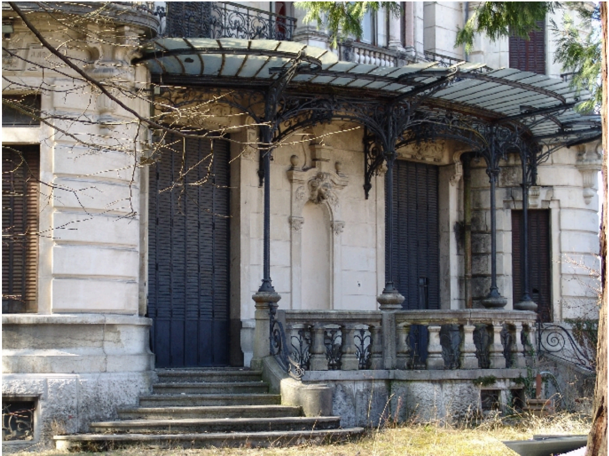
Perron et marquise de la façade latérale nord
