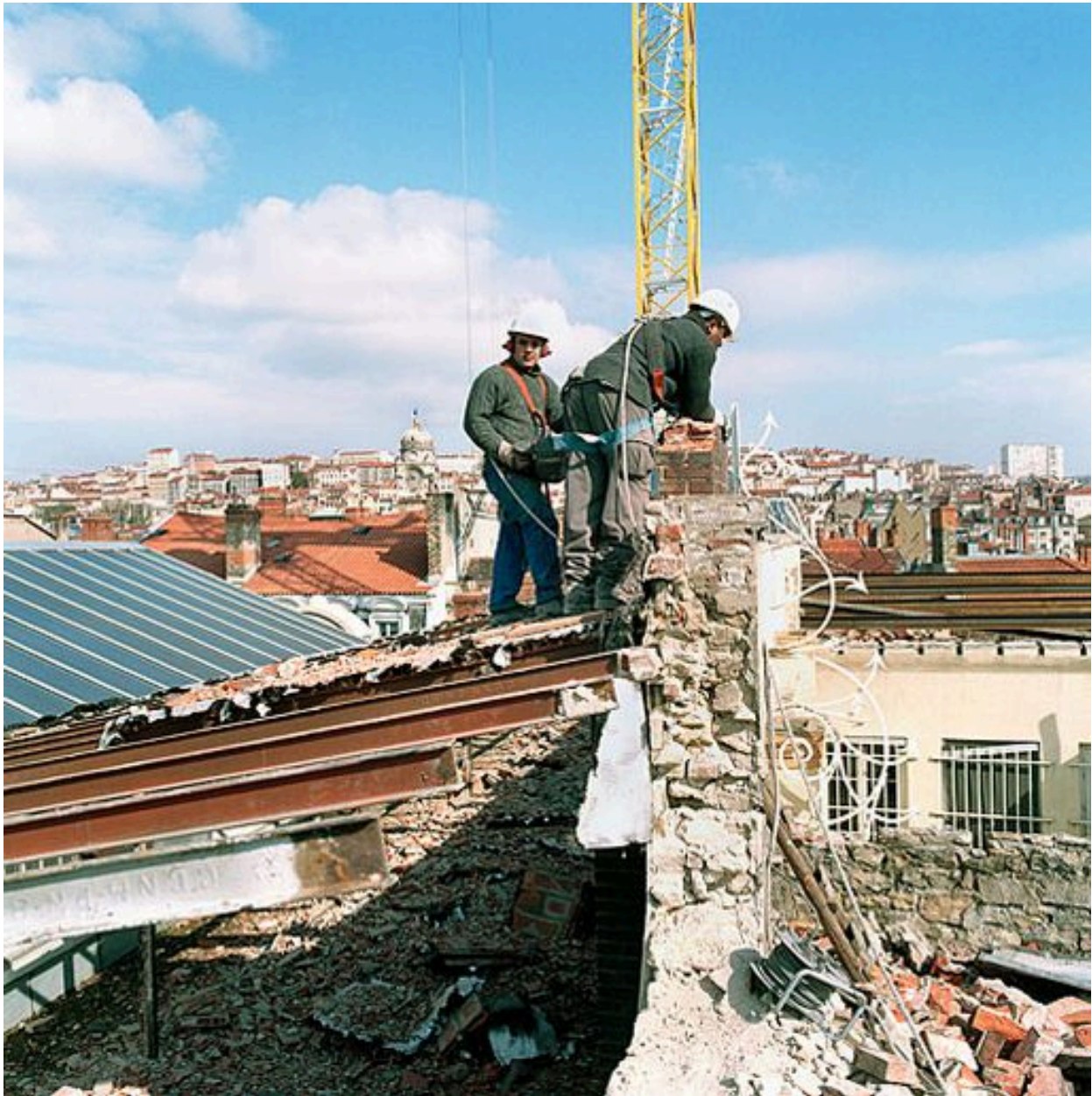
Toit en cours de démolition, détail du mur mitoyen séparant l'immeuble de celui de la banque
