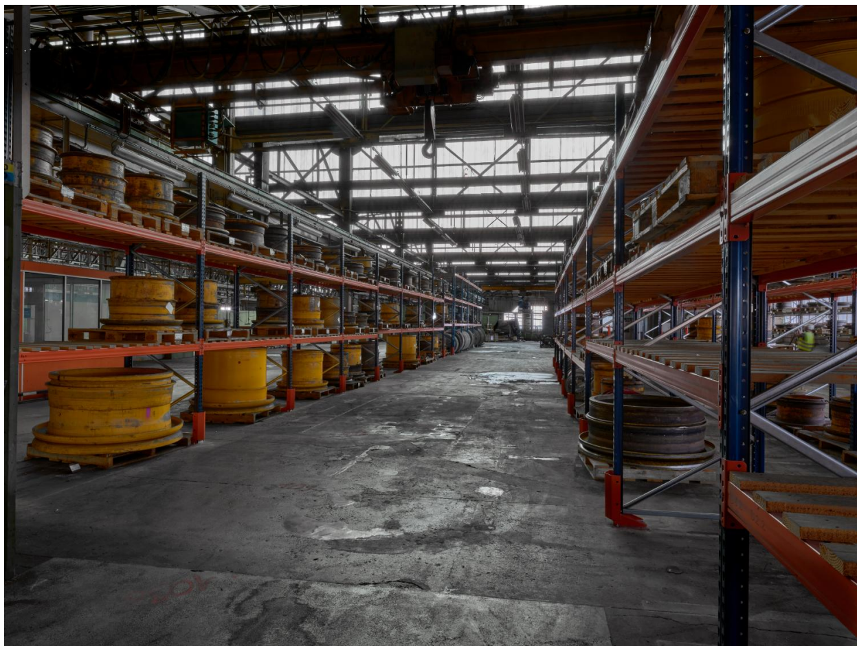
Intérieur de l'atelier V22, désaffecté.
