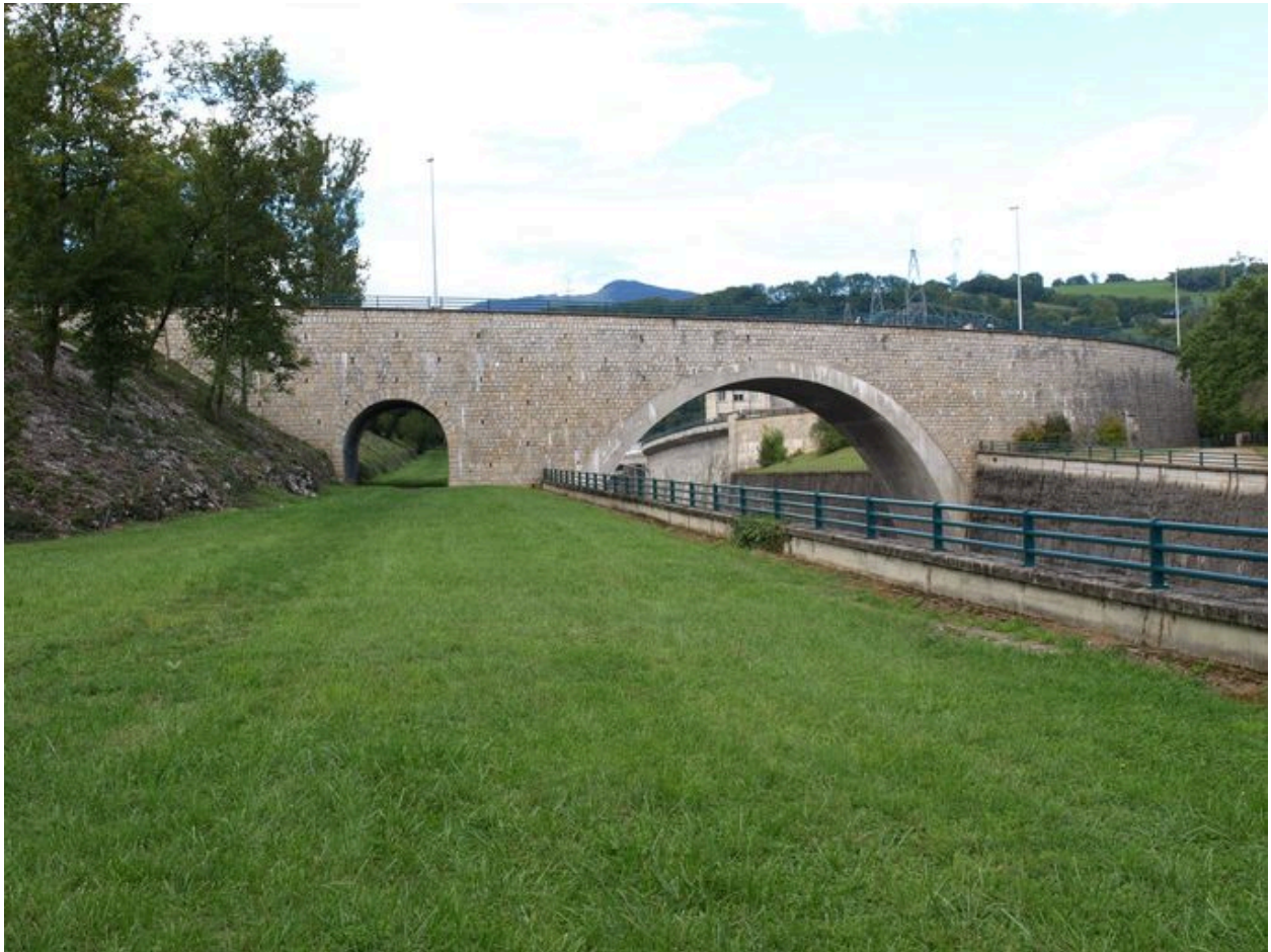
Vue générale, face amont
