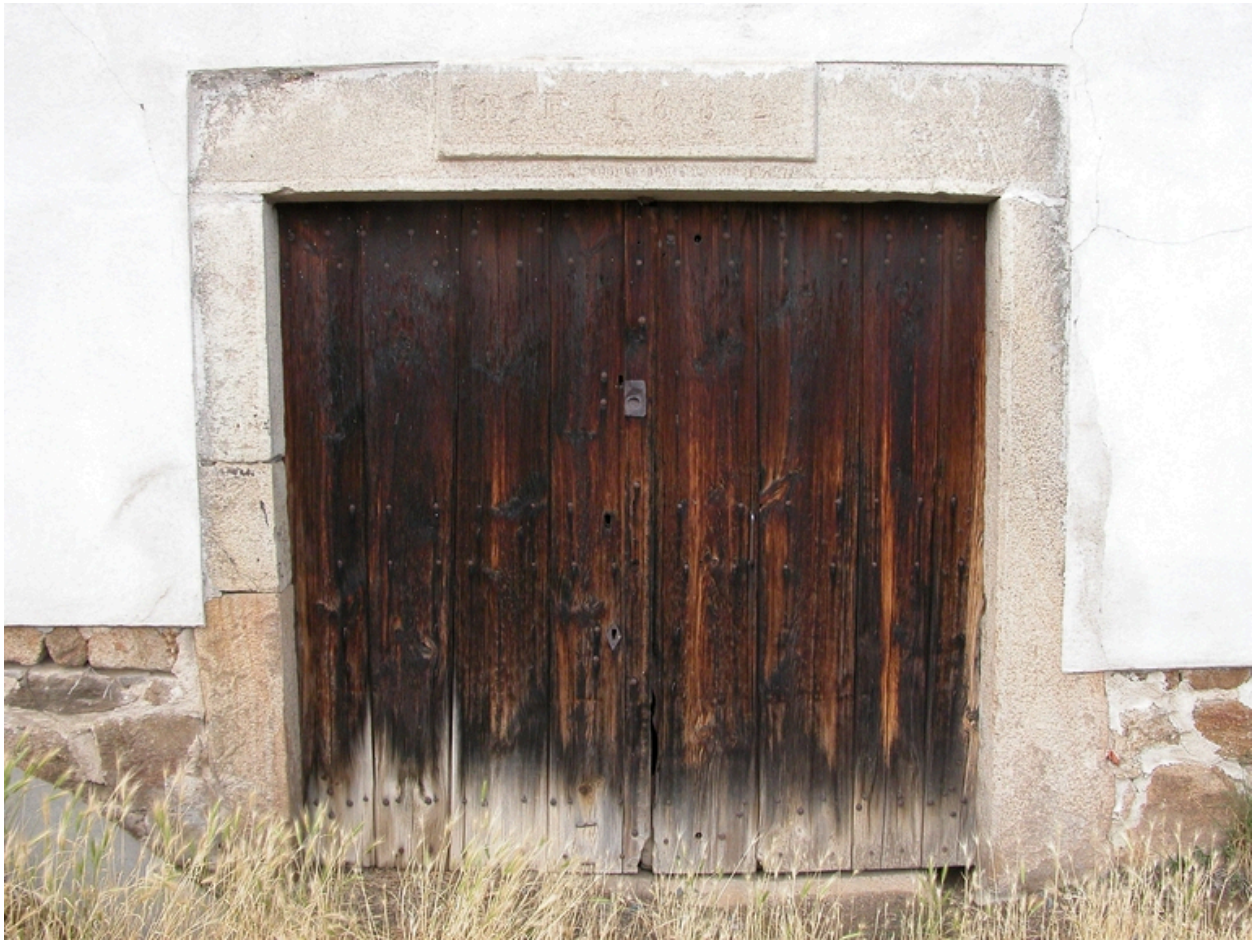
Détail de la porte.
