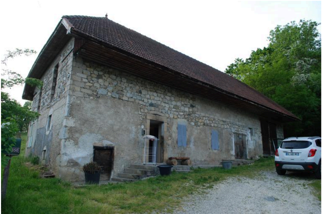
E6 431, 388, ferme. Vue d'ensemble du corps de bâtiment principal.
