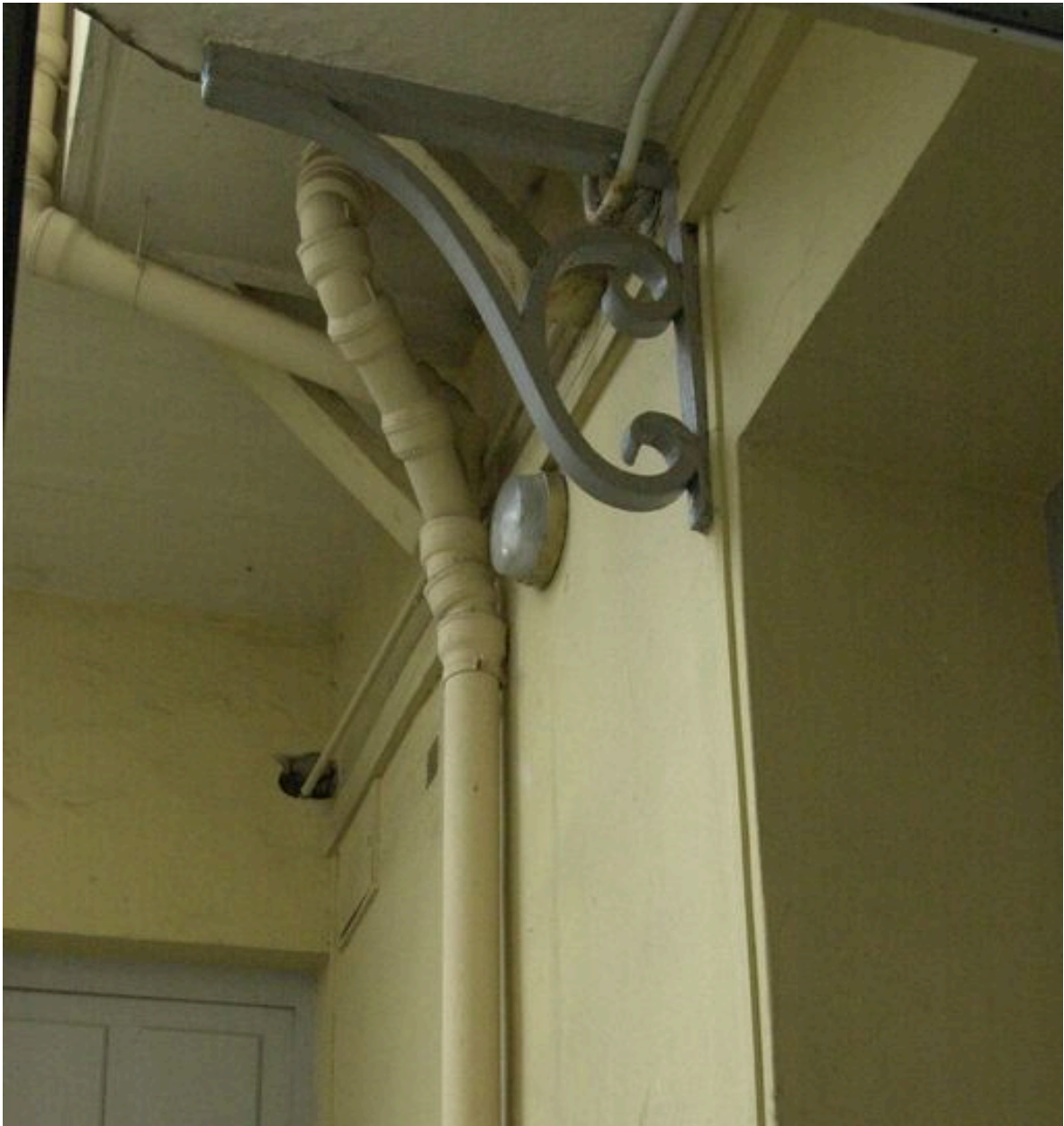
Détail de la console supportant la coursière
