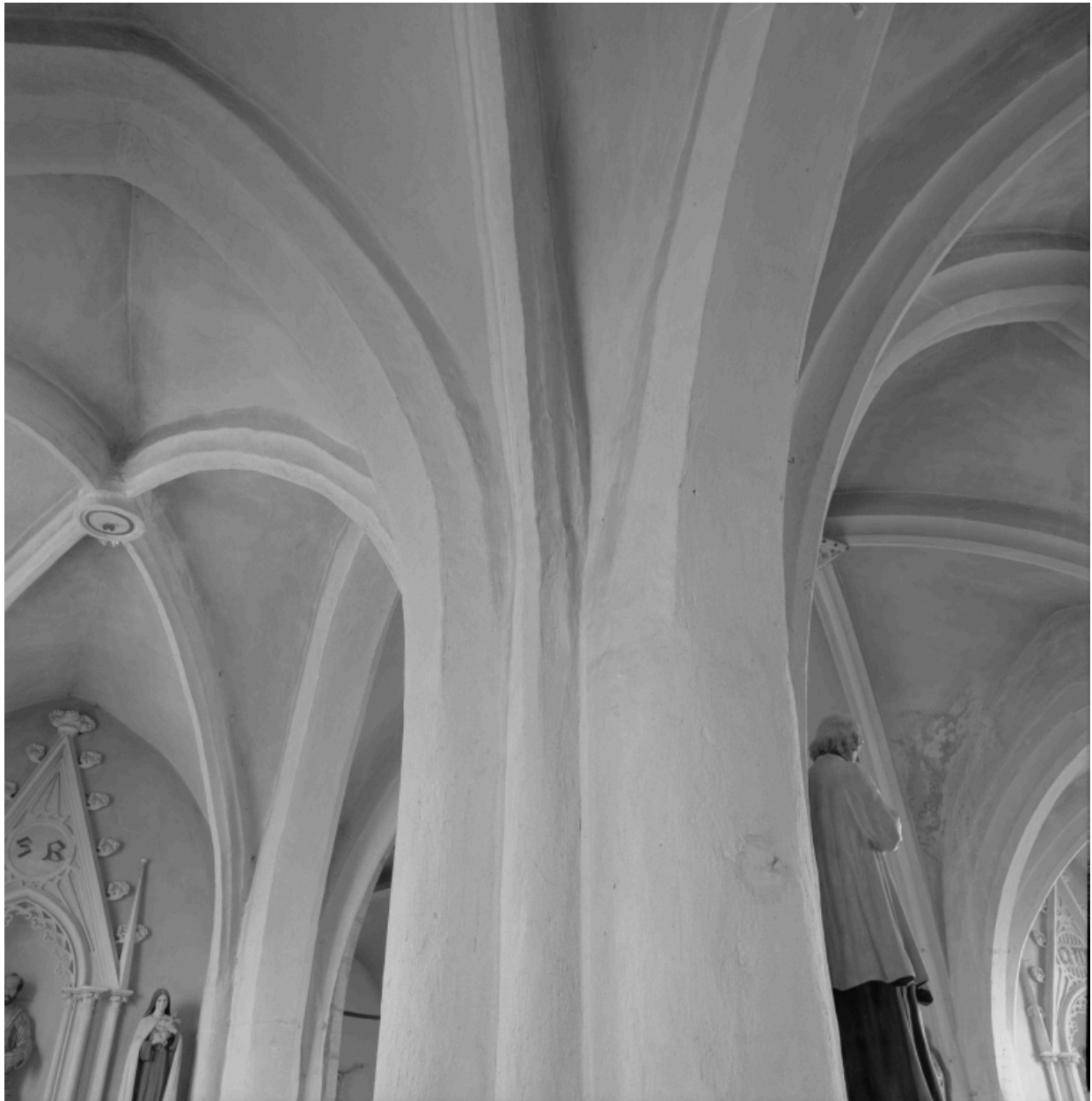
Voûtes du bas-côté nord.
