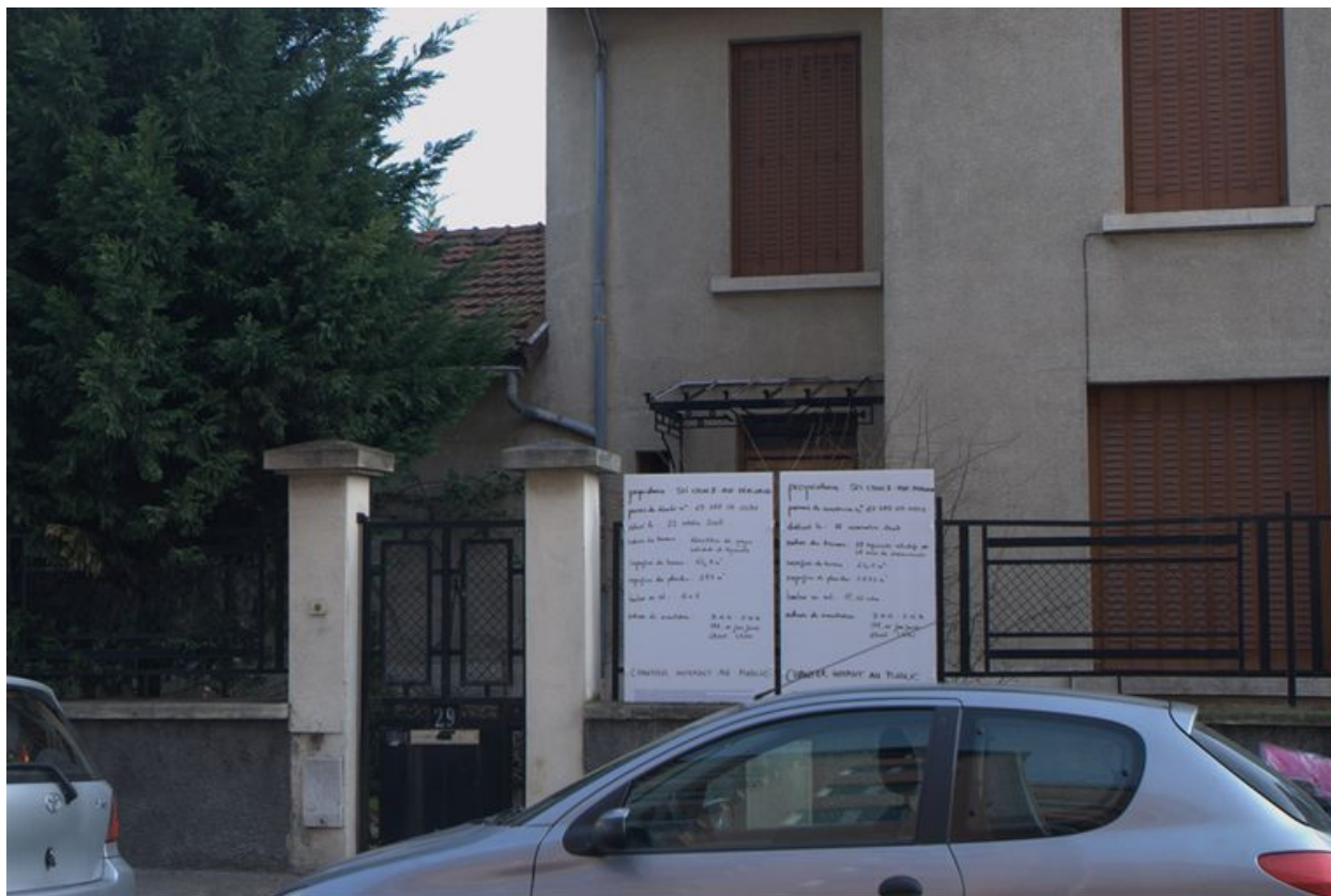
Elévation antérieure, détail de la marquise
