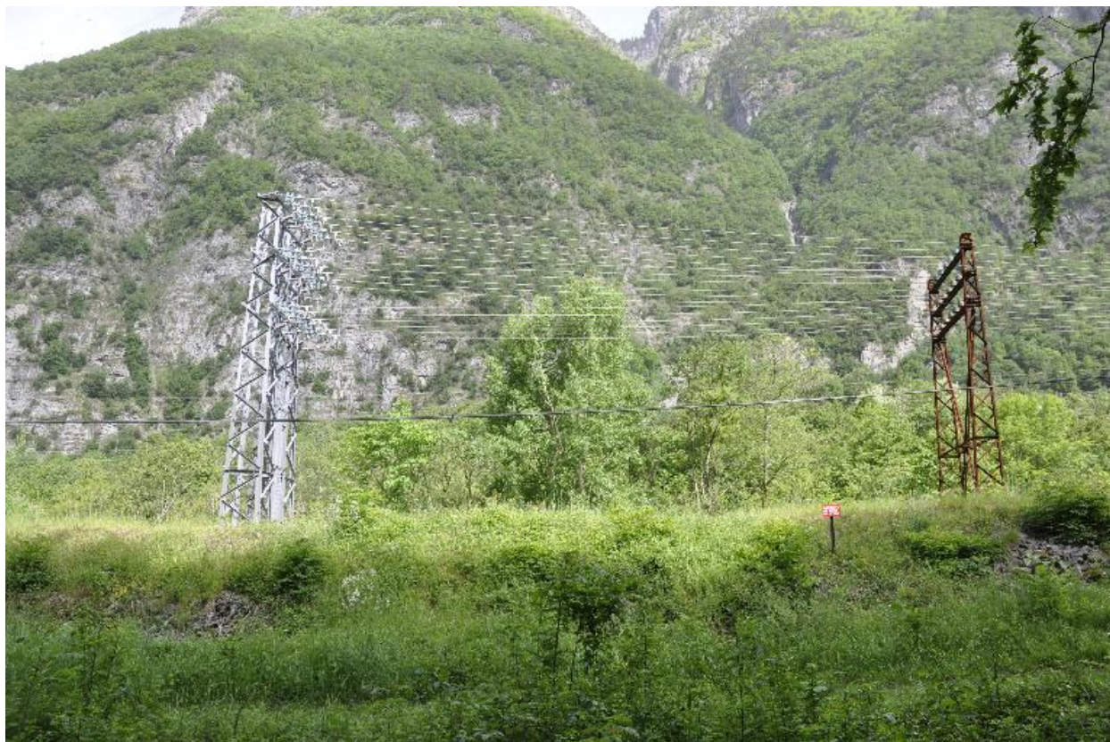
Vue des pylones et des lignes à haute tension
